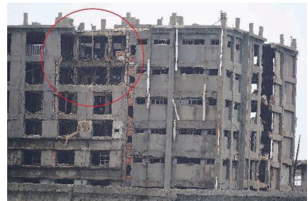
写真-5 2020年6月の30号棟一部崩落 （提供：町田信二氏）
