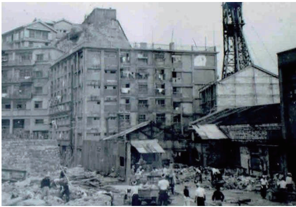
写真-2 1956年9月台風12号後の南部復旧工事現場。 写真奥が30号棟（後藤恵之輔所蔵）
