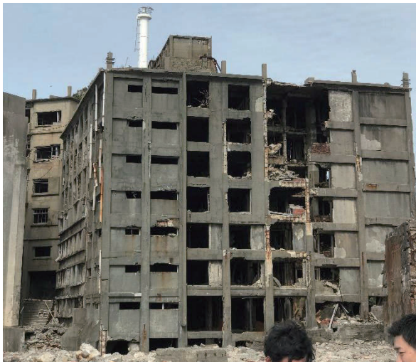
写真-4 2020年3月の30号棟一部崩落 （提供：久遠裕子氏）
