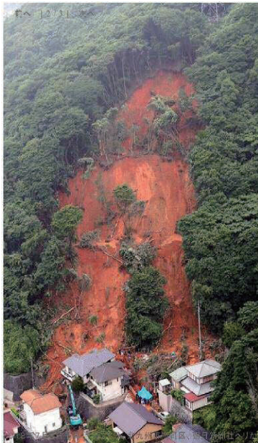
図-3 2018年7月6日に発生した裏山崩壊
