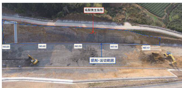
図-8 切土後に開口亀裂が発生（開口亀裂①）
