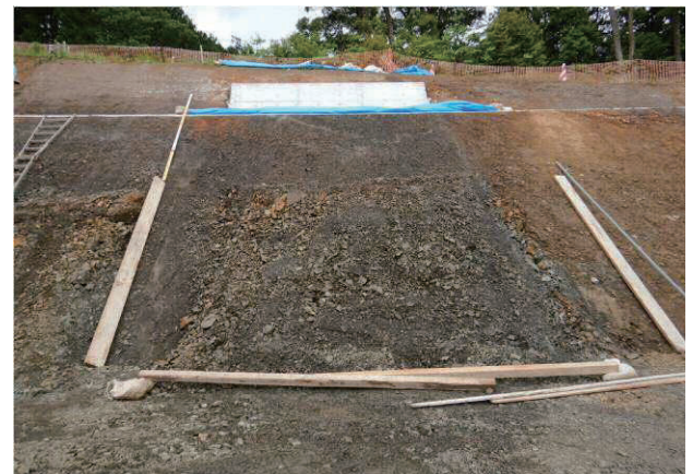
図-14 「のり面のせり出し①」発生(2019年6月7日)
