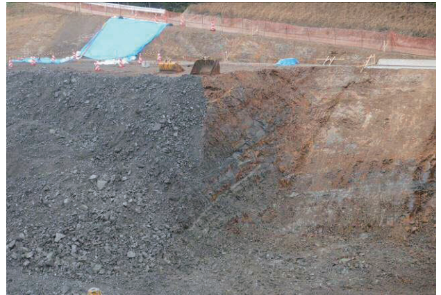
図-13 再掘削のり面状況(流れ盤)(2019年2月12日)
