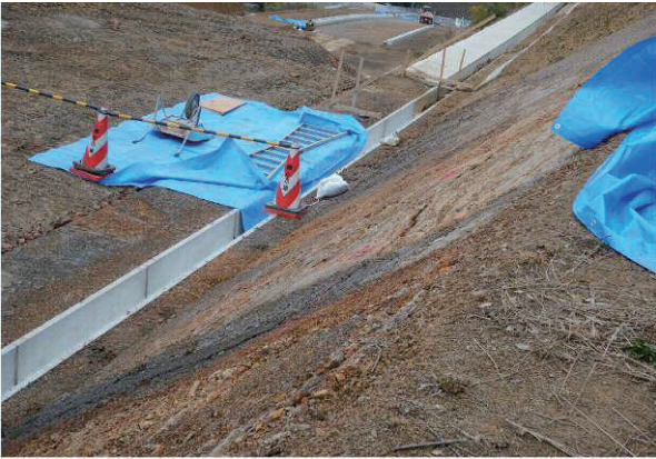
図-11 切土後に開口亀裂②が発生 (2018年12月6日)
