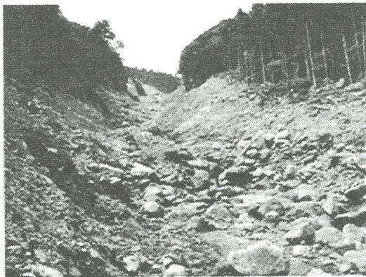
(b) 土石流の流下区間 (流路中央から上流方向を望む)
