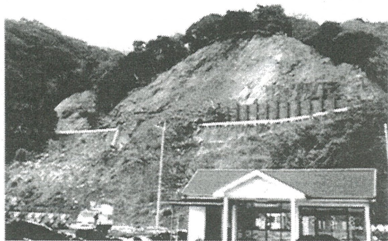
写真-1 道路法面崩壊現場 (F県, 2002年3月)
