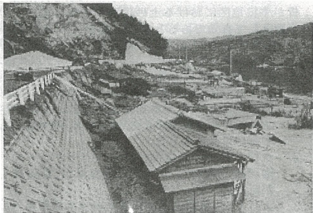
写真-1 牛根地区の土砂流出直後の写真（1976年撮影）
