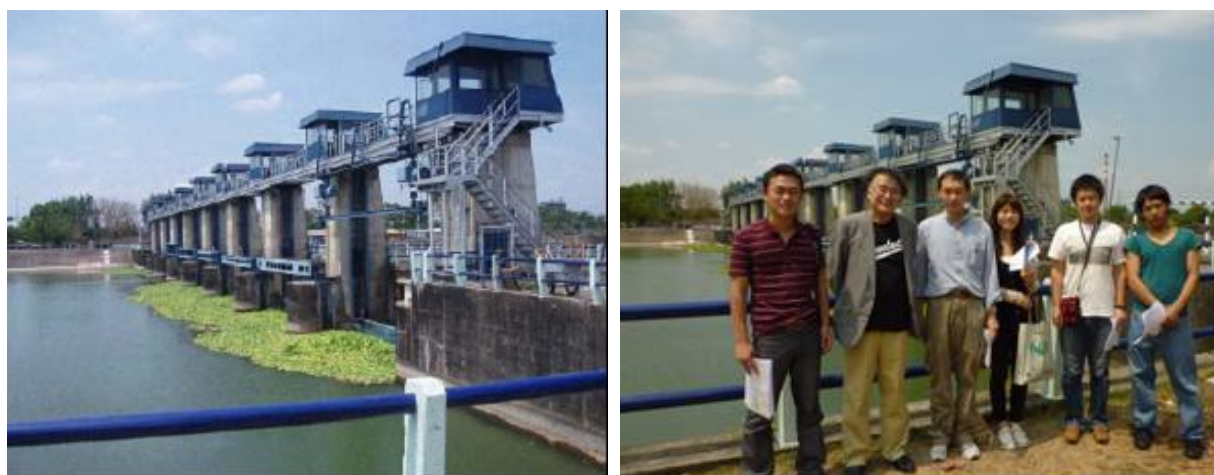
図-1.2.2 新レンコン・ダム
