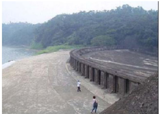
図-1.4.2 烏山頭水庫の放水路と洪水吐
