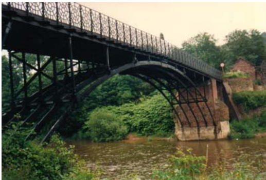
写真 23 補修前のコールポート橋
