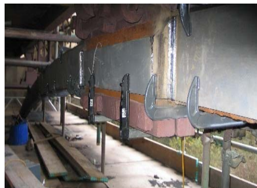
写真 25 鋼板接着によるアーチリブ断面補強
