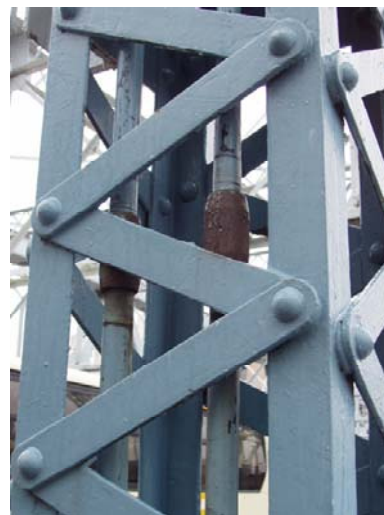
写真 3, 4 犀川大橋の垂直材のPC鋼棒による部材補強
