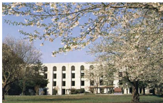
写真-4 改修後の笹流ダム
