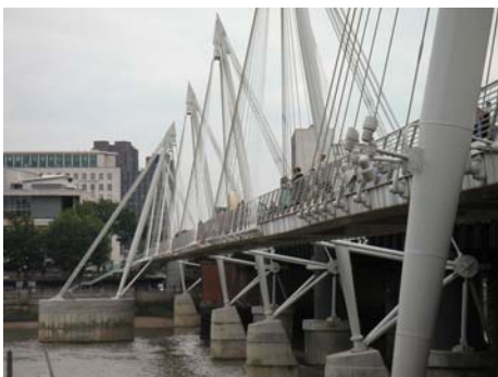
写真 17 ハンガーフォード歩道橋
