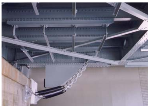
写真 13 群馬大橋の補強(縦桁, 耐震補強)
