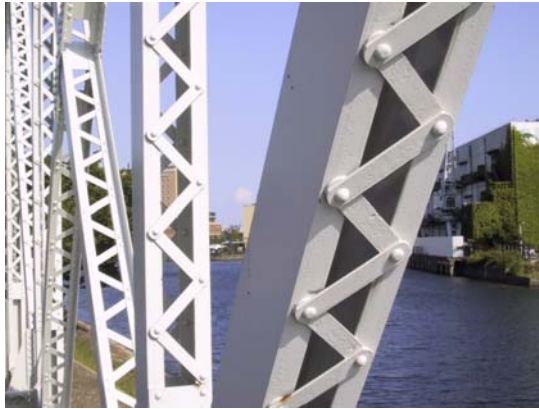
写真 1. リベットとレーシングバーで形成された部材
