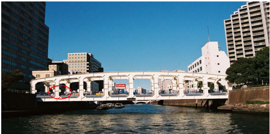
写真8. 豊海橋（垂直材の両側面に照明装置が追加された）
