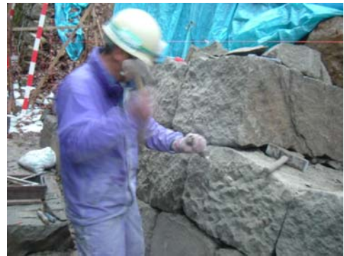
写真-4 伝統的技法での石垣修復
