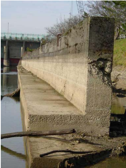
写真－5 大河津分水路洗堰の側壁断面 (1922年完成)
