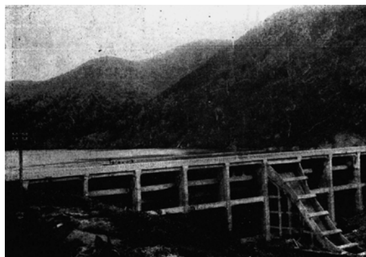
写真-5 改修前の手井ダム
