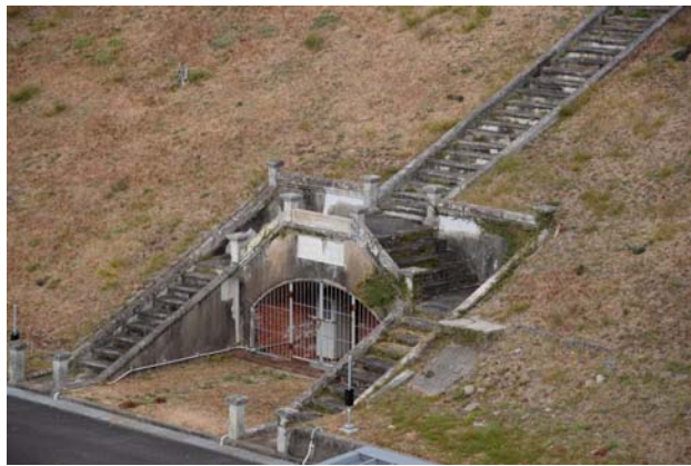
写真-4 本河内高部ダム下流面の底樋と階段
