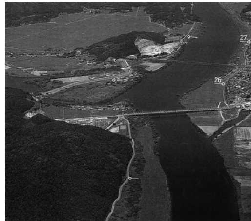
図4 北上川分流施設を俯瞰する 5)
