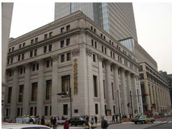
図 3 三井本館と三井タワー
