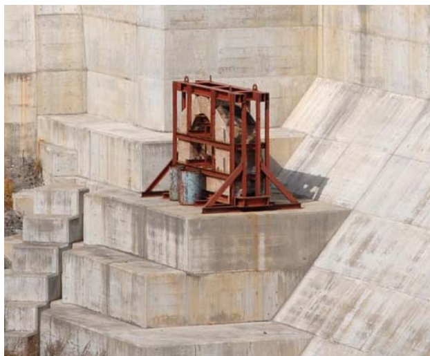
写真-5 輪切りにされた本河内高部ダムの取水塔
