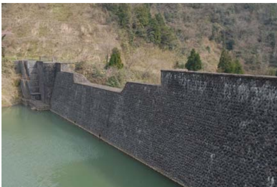
写真-10 改修後の美敷ダム(上流側) (撮影:樋口輝久)
