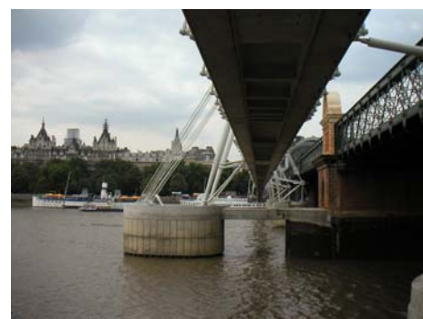
写真 20 鉄道橋(右)と歩道橋
