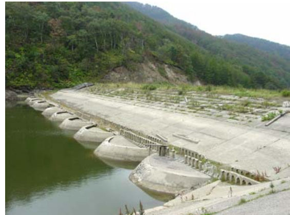
写真-7 改修後の手井ダム（上流側） （撮影：樋口輝久）
