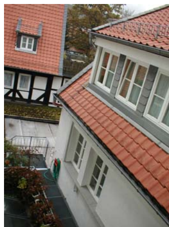
図 4-2 歴史的建造物 にあわせて目 立たなくつく った防火シャ ッターのボッ クス
