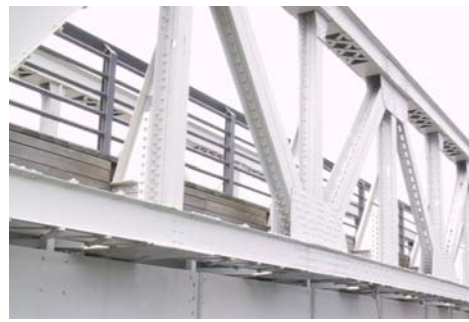
写真 16 リベットで再製作された下弦材
