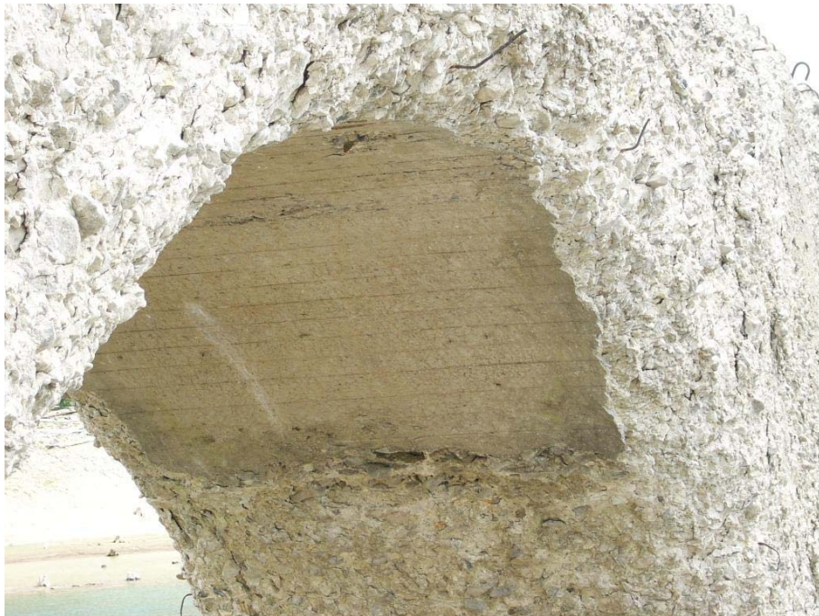
写真-8 タウシュベツ橋梁の近撮（北海道） （材料耐久性として眺めると、劣化の顕在化は著しい）
