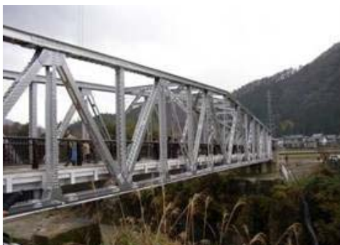
写真 5, 6 金名橋の下弦材のPCケーブルによる部材補強
