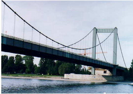
写真 21 拡幅前のローデンキルヘン橋
