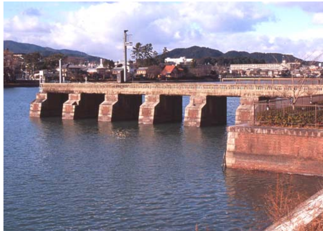
写真. 6 旧南郷洗堰の現況
