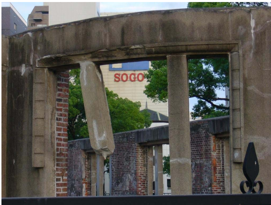
写真－4 原爆ドームにおける保存・修復の状況 （曲がった柱はそのまま曲がったまま保存する）
