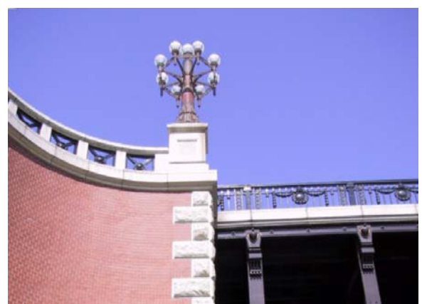
写真 29 復元された橋灯と高欄
