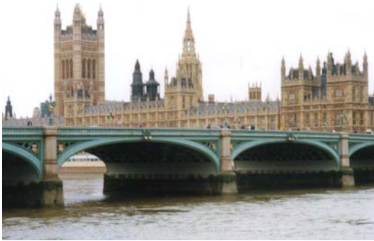
写真 26 補修・補強された Westminster 橋
