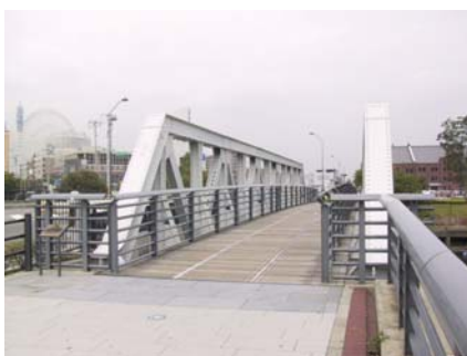
写真 15 再生の例(新港橋梁)
