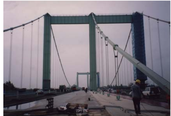
写真 22 拡幅後のローデンキルヘン橋
