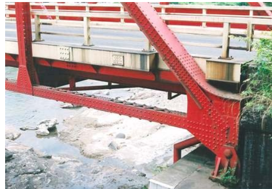
写真9. 下路トラスの鋼床版化例
