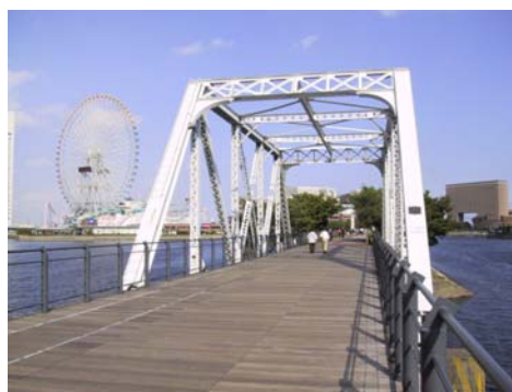
写真 10. 木床版化の例(港一号橋)
