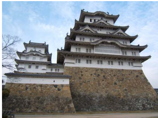
写真-1 姫路城天守と石垣
