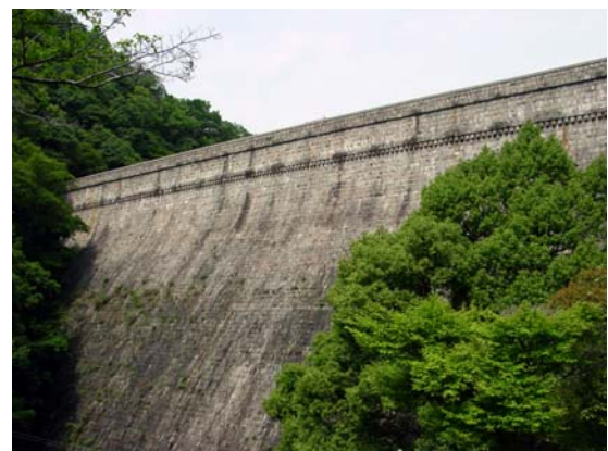
写真-8 改修後も外観の変化はない 布引ダムの下流側 （撮影：樋口輝久）
