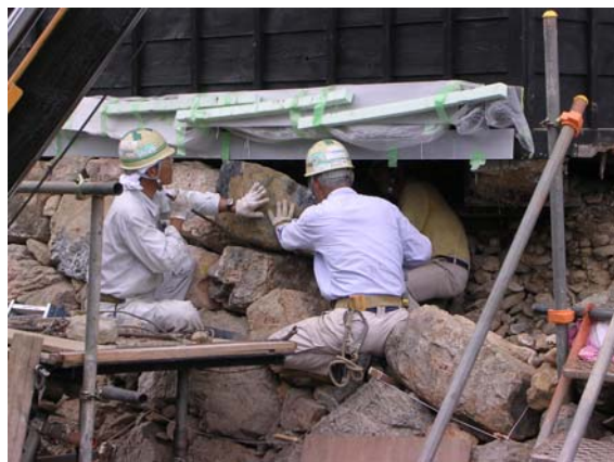
写真-3 石垣積み直し状況
