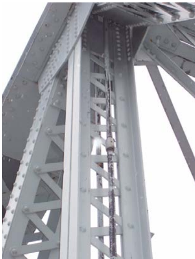
写真 3, 4 犀川大橋の垂直材のPC鋼棒による部材補強
