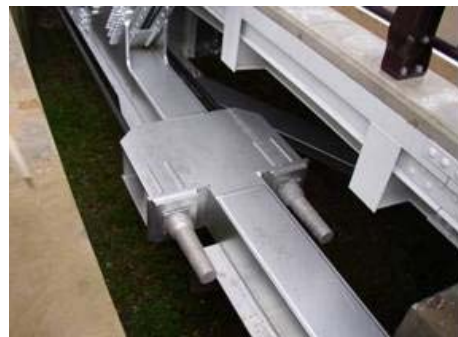
写真 5, 6 金名橋の下弦材のPCケーブルによる部材補強
