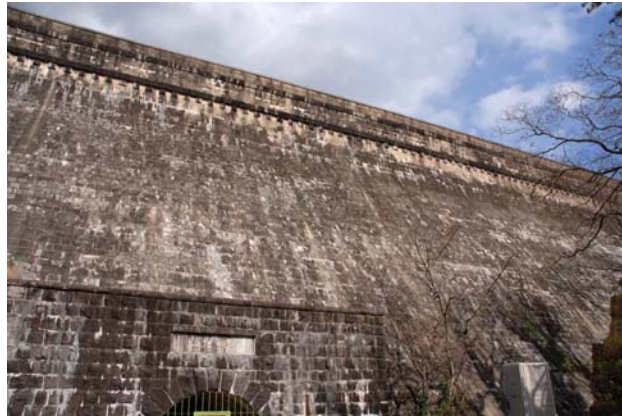
写真-3 本河内低部ダム
