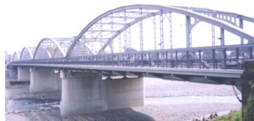
写真 14 群馬大橋の外観
