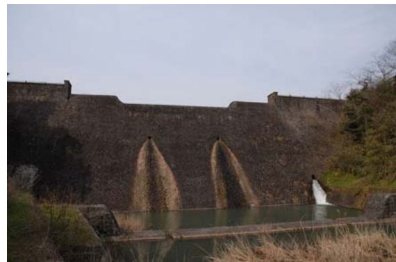
写真-11 改修後の美敷ダム(下流側) (撮影:樋口輝久)
