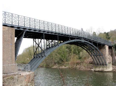
写真 24 補修・補強されたコールポート橋
