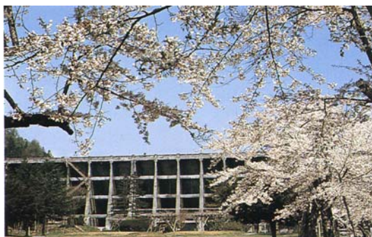
写真-3 改修前の笹流ダム
