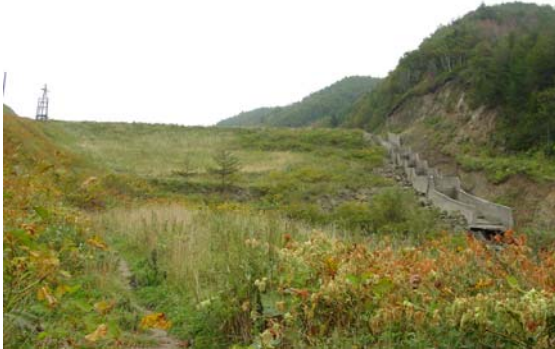
写真-6 改修後の手井ダム（下流側） （撮影：樋口輝久）
