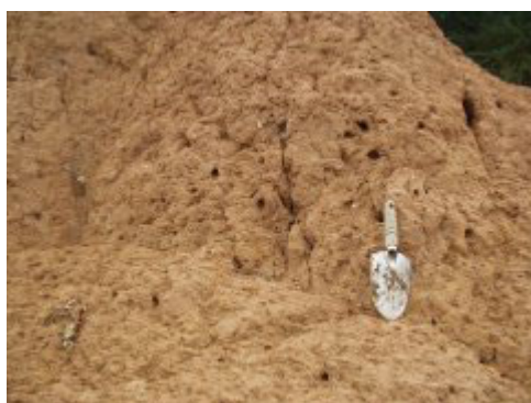
一部流出による侵食痕跡がある
