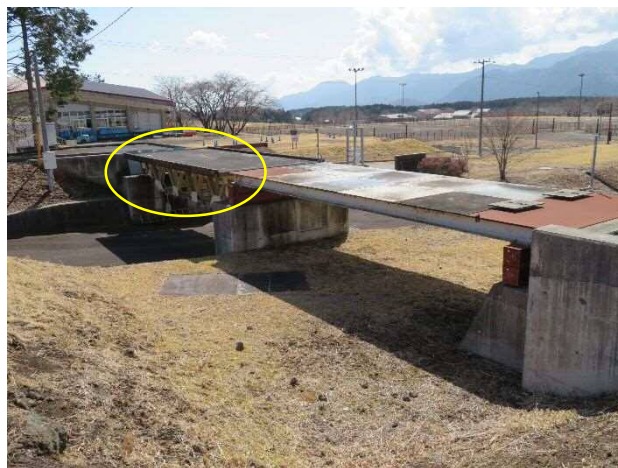
写真 3. 2. 5 暴露試験状況 (5) : FRP 成形材を用いたトラス部材
