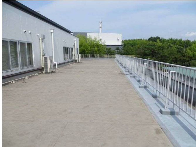
写真 3.2.7 八幡・構造実験センター 暴露場
