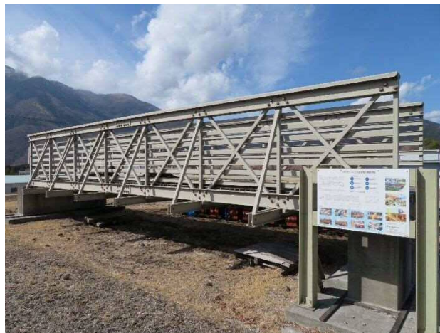
写真 3. 2. 4 暴露試験状況 (4) : FRP 成形材を用いたトラス部材
