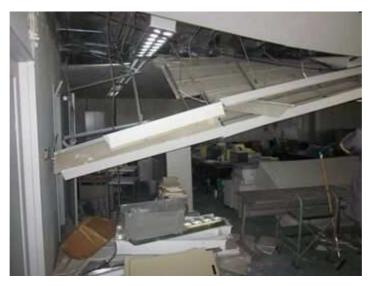
図8:空港ビル3階事務所室内の被災状況(仙台空港ビル㈱提供)
