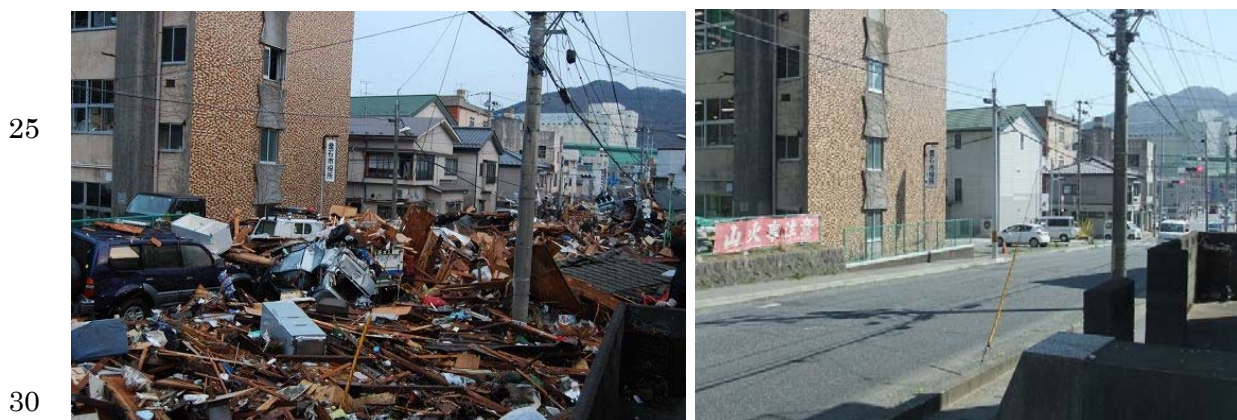
図13：釜石市役所付近の道路の状況
