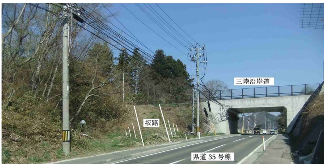
図 20 : 県道 35 号線と三陸沿岸道路交差部に取り付けた坂路
