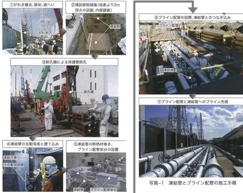
図3-59 陸側遮水壁の施工手順
