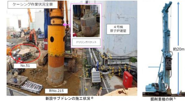
図3-47 新設サブドレンの施工状況
