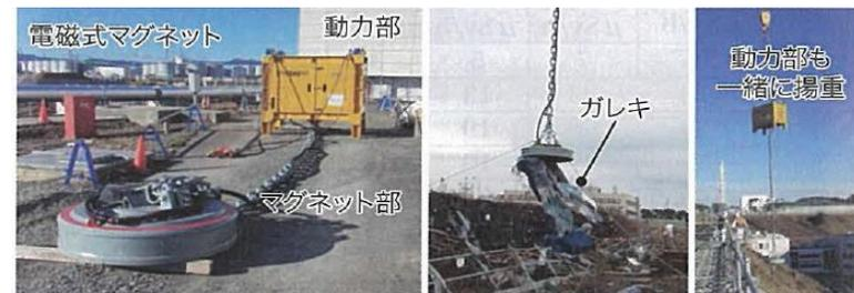
図 3-83 がれき撤去装置と施工状況
