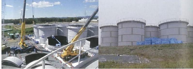
図 3-105 フランジ型タンク(左-組立中、右-完成)
