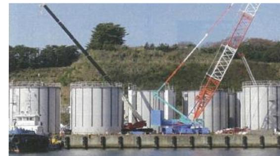
タンクの組立・溶接・水張り試験は福島第二原子力発電所での作業となるため、**作業時間の制約や放射能保護具が不要となり、作業効率が格段に向上した。**
