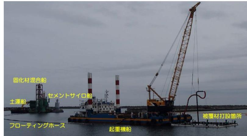
図 3-130 施工状況(第2期工事)
