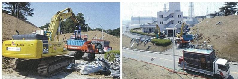
バックホーでがれきを運び、クローラードンプに積んだコンテナに載せる様子。右写真右下が移動式遠隔操作室である。
