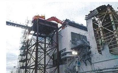
橋台の上に重機を上げてタービン建屋の排気ダクトを解体した。
