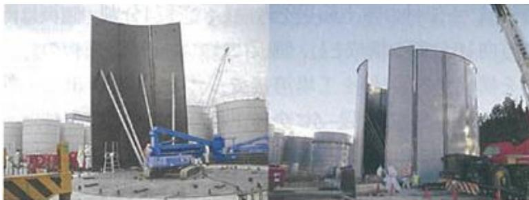
図 3-117 仮組の状況(底板設置～側板建込み)
