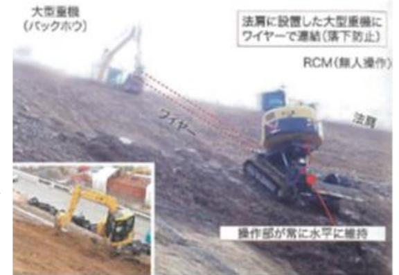
図 3-82 RCMによる施工状況
