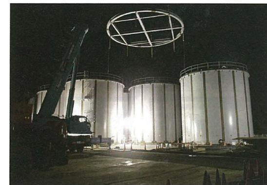
水張り試験は実施済みのため、設置後、底板の溶接線について磁粉探傷検査(MT)を行い、欠陥がないことを確認して供用を開始した。これにより、**供用開始までの時間が大幅に短縮された。**
