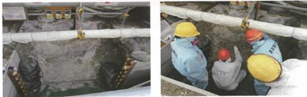
図 3-67 凍結状況(掘削調査、2018年3月)
