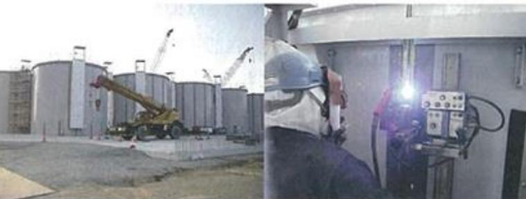
図 3-118 側板の溶接状況(左:溶接足場、右:溶接状況)
