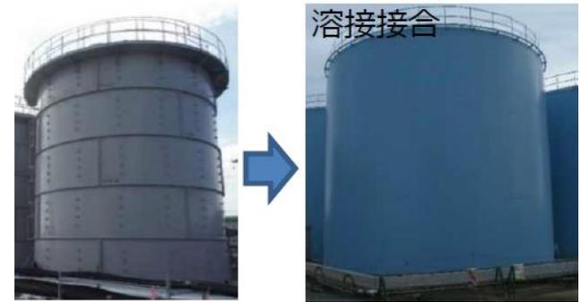
図 3-108 溶接型タンク(貯水容量1,200m<sup>3</sup>/基)
