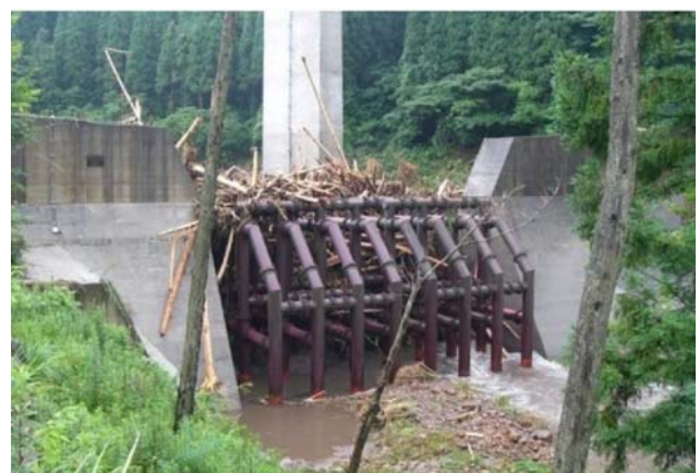
図 2.3.9 鋼製透過型砂防堰堤 2-44)
