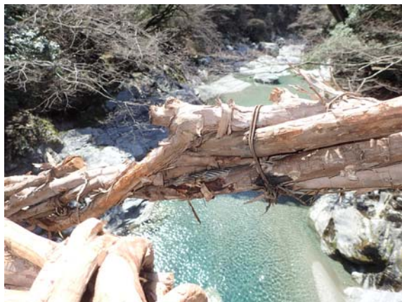
(c) かずらが被覆されたケーブル
