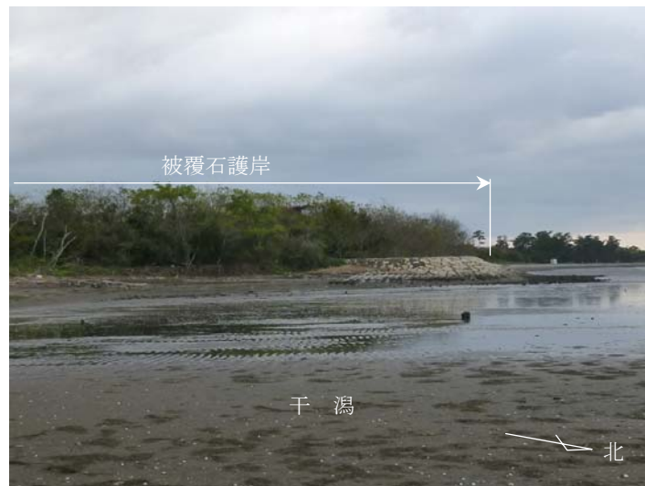
写真 2.4.3 干潟から見た被覆石護岸
