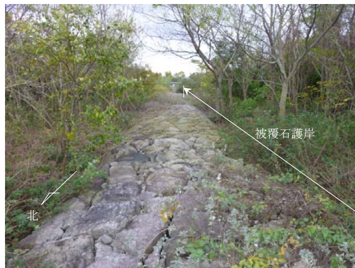
写真 2.4.4 陸側の被覆石護岸
