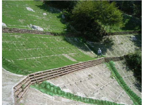
図 2.3.14 丸太を用いた土留工 2-51)
