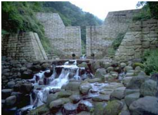
(a) スリット砂防堰堤 2-48)
