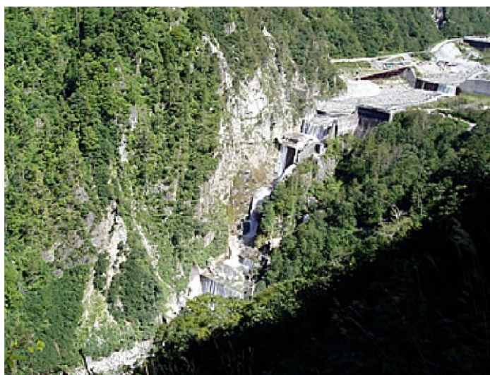
図 2.3.4 白岩砂防堰堤 2-39)
