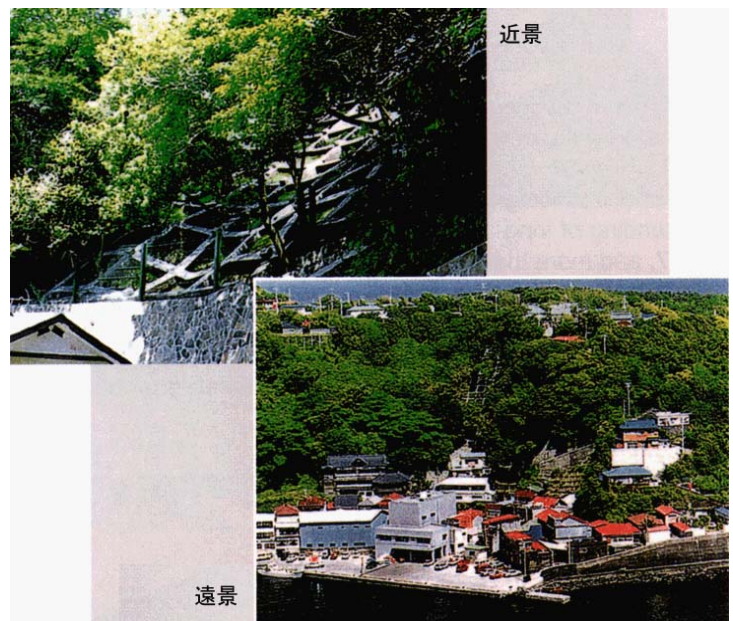
図 2.3.13 既存木を保存した法枠工 2-50)
