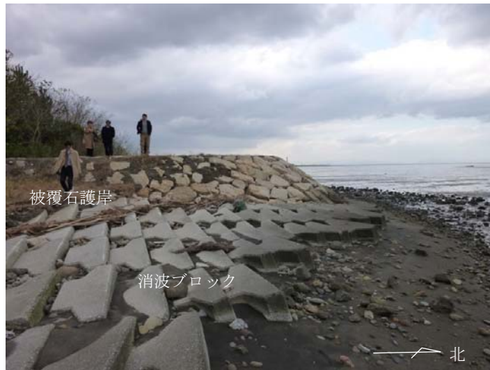
写真 2.4.5 被覆石護岸の側面
