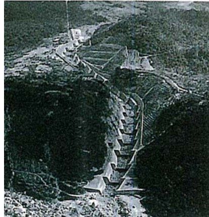
砂防施設完了直後
