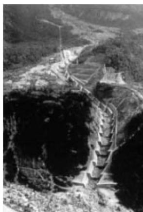
砂防施設建設途中(昭和 8 年)
