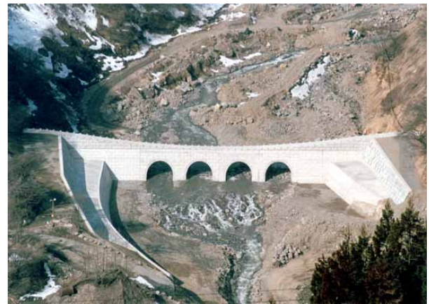
(b) スーパー暗渠砂防堰堤 2-49)
