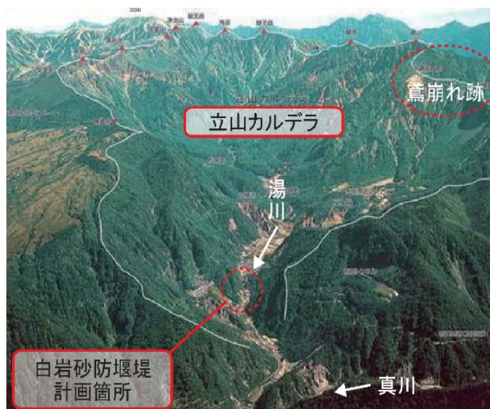
図 2.3.1 鳶山崩れと白岩砂防堰堤 2-37)
