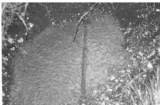
写真1 緑化部分のコンクリート表面...施工当時そのままを思わせる新鮮な表面
