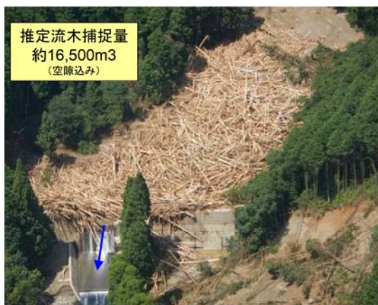
図 2.3.8 土石流および流木を止めた砂防堰堤 2-43)
