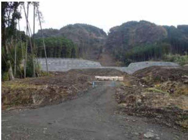
写真 3.3.3.1 砂防堰堤
