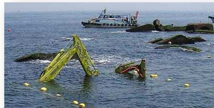
水中バックホウによる障害物撤去状況
