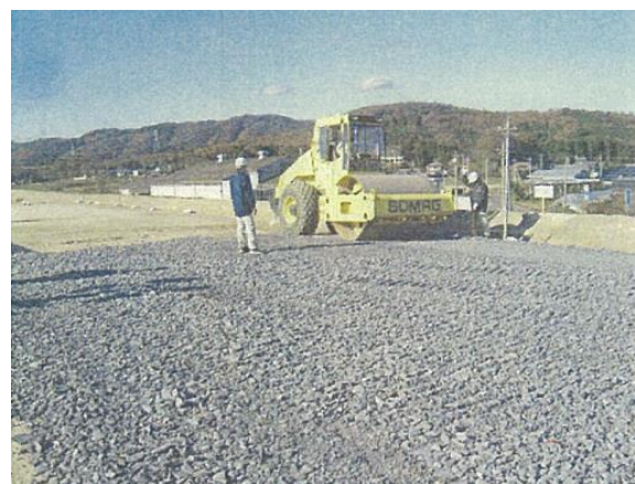
b) 転圧状況
