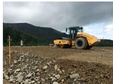
写真 5.1.1 振動ローラによる現場転圧状況
