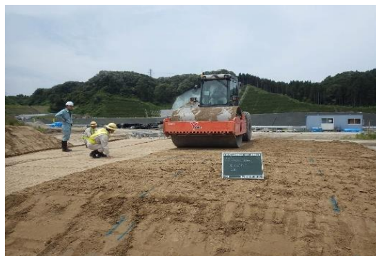
写真-5.6.2 現場転圧試験の状況
