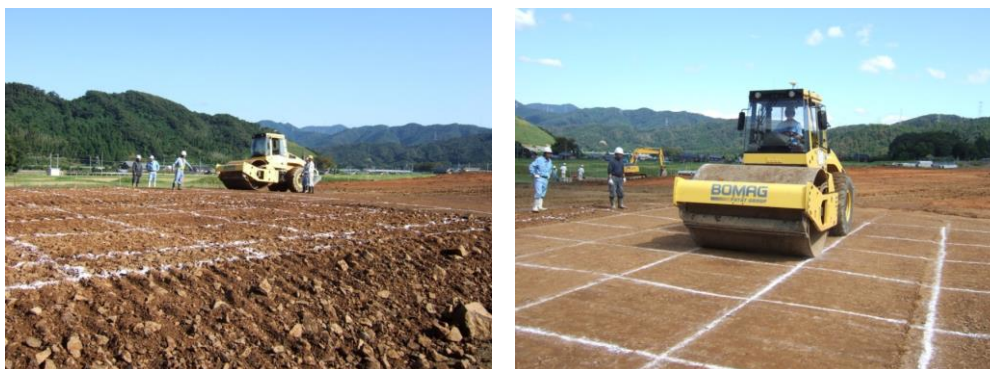
写真-3.3.1 モデル施工（転圧試験）の実施例
