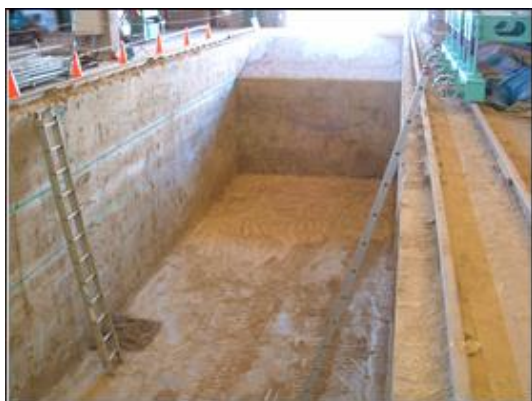
写真-4.3.1 実験ピット（初期状態）
