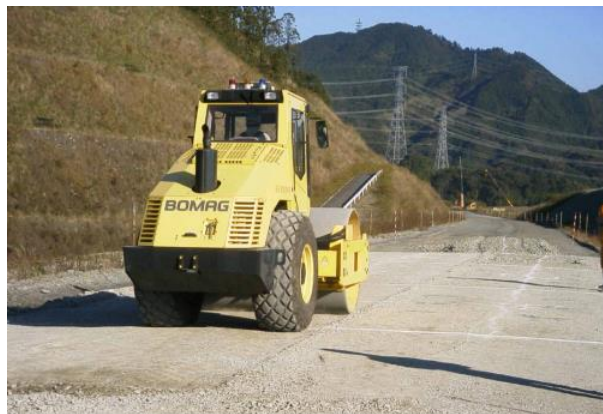
b) 転圧状況
