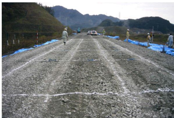
a) ヤード全景転圧前
