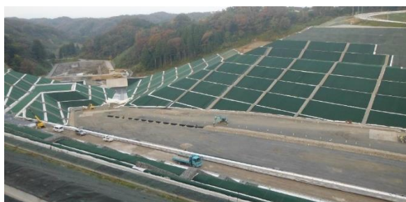
写真-5.6.1 施工現場概観
