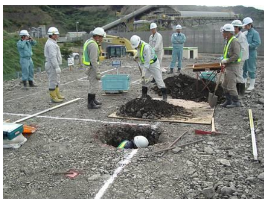
写真-3.2.3 水置換法における置換孔掘削
