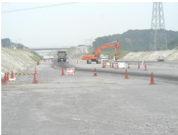
a) 施工状況
