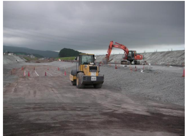
b) 転圧状況
