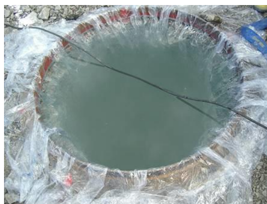
写真-3.2.4 水置換法における水張り
