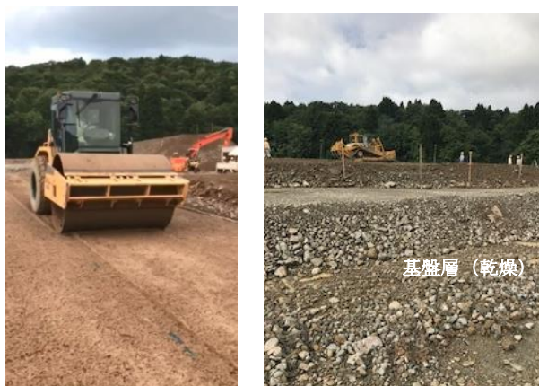
写真 5.1.2 (a) ロック (80 cm) の転圧状況 (b) 基盤層
