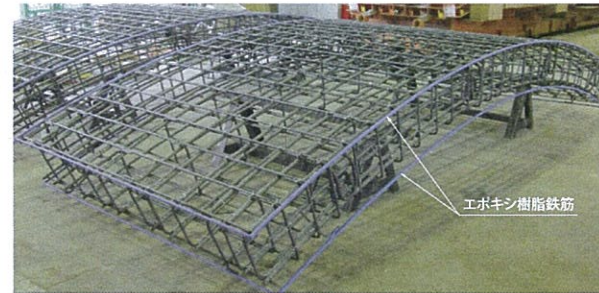
鉄筋がご組立状況
