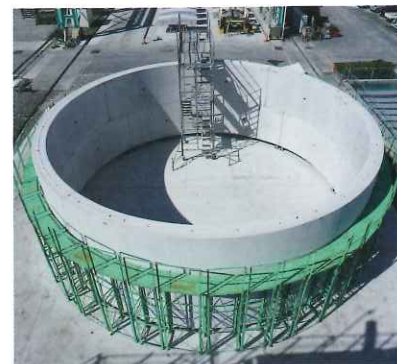
仮組立状況 (1リング9ピース) 外径: Ø12.4m 内径: Ø11.5m
