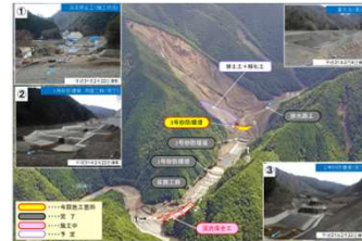
赤谷3号砂防堰堤施工箇所
