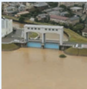
洪水時の水門。本川の水位が高くなった際に、水門を閉鎖することで、本川の洪水を支川に逆流させないようにしています。
