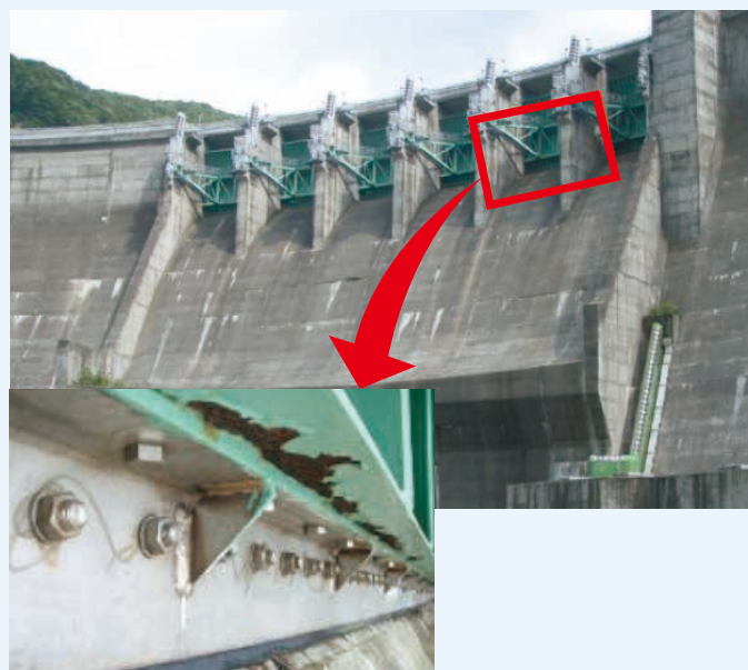
非常用放流設備（クレストゲート）の老朽化による腐食状況の事例。このままでは腐食が進行し、構造物の機能に支障が生じる可能性があるため、早期に措置をする事が望まれます。
