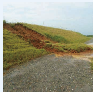
雨水の堤防への浸透に起因して法崩れが発生した様子。堤防機能に支障が生じており、直ちに措置を要します。
