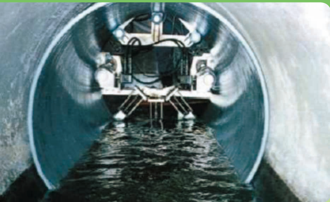
更生工法による下水道管の修繕と改築 (国土交通省資料)
