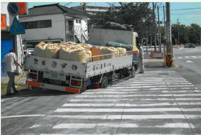
道路陥没による交通障害（国土交通省資料）
