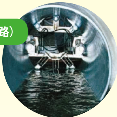
更生工法による下水道管の修繕と改築
