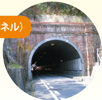
小坪隧道・名越隧道
