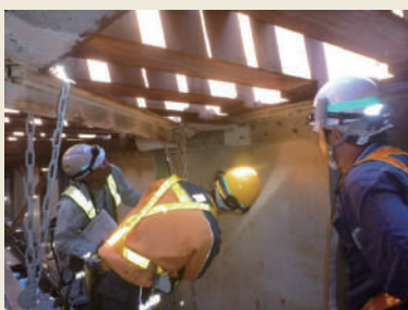
橋梁の検査状況
