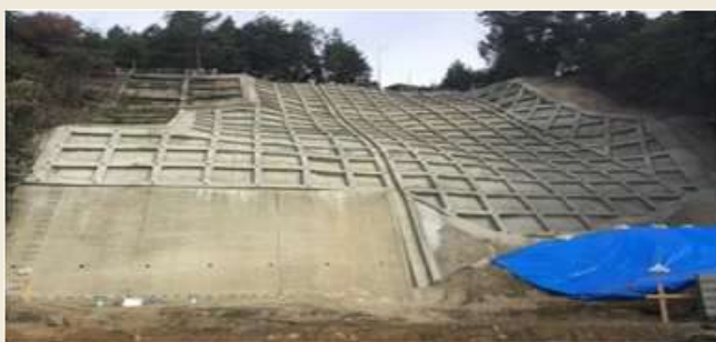
コンクリート枠による斜面の補強
