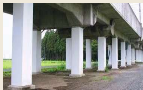
鋼板巻きによる高架橋の耐震補強
