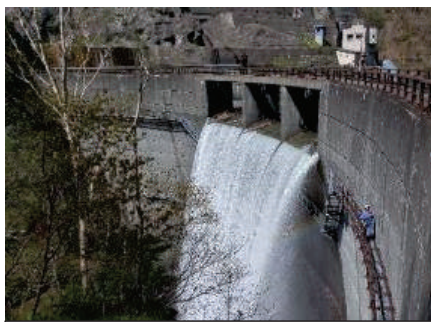
コンクリートダムの表面劣化の点検作業
