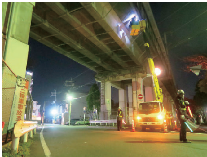
橋梁の検査状況
