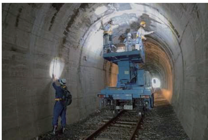
トンネルの検査状況
