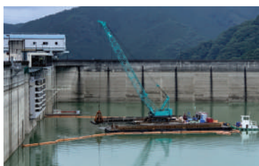
ダム堤体の放流設備付近に貯まった土砂を撤去している状況です。
