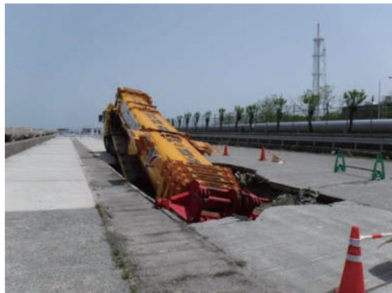
臨港交通施設（道路）陥没による車両被害
