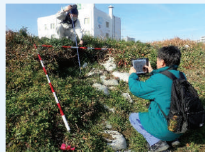
堤防の点検状況。洪水から地域が守られるよう定期的な点検・評価によって、河川管理施設の状況を確認。
