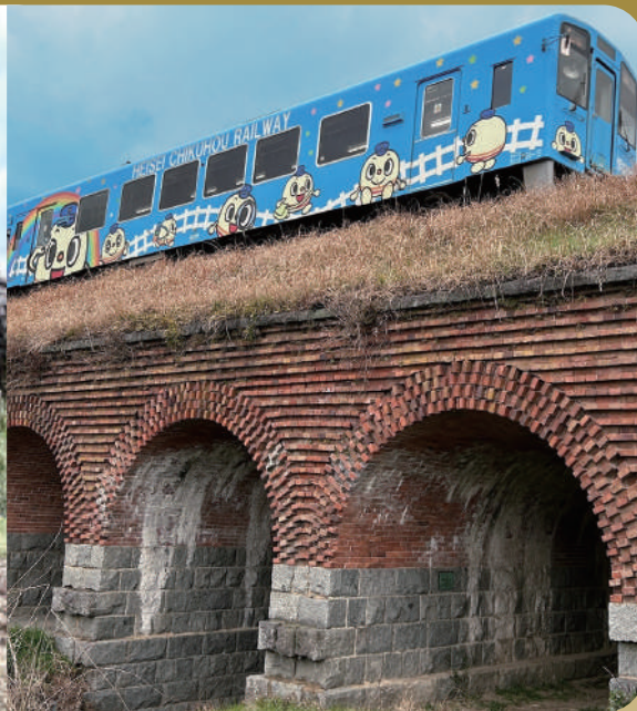
平成筑豊鉄道 内田三連橋梁 煉瓦造 3 連アーチ橋 1895 年、経年 129 年 筑豊地方の運炭鉄道網拡充のために 設立された豊州鉄道株式会社が油須原 ―香春間に建設した橋長 17 m の煉瓦 造 3 連アーチ橋
