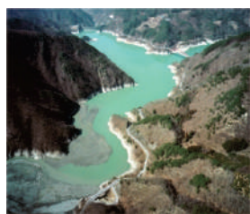
ダム貯水池の堆砂の状況。貯水池上流部において堆砂が生じていることが確認できます。貯水容量を確保するため定期的な維持掘削を実施しております。
