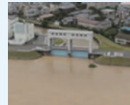
洪水時の水門。本川の水位が高くなった際に、水門を閉鎖することで、本川の洪水を支川に逆流させないようにしています。
