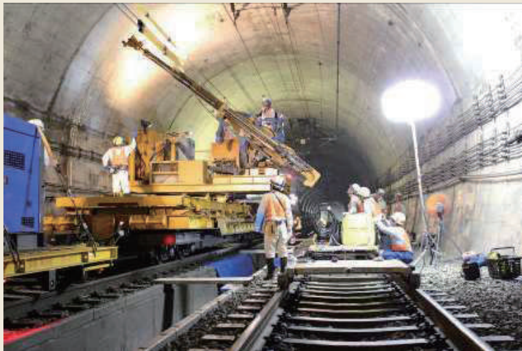
トンネルにおける大規模改修工事（ロックボルト工）
