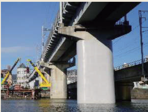
橋脚の耐震補強
