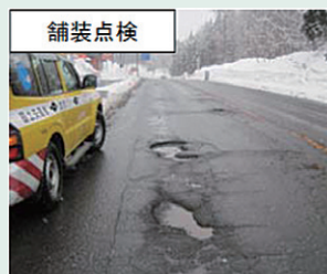
パトロール車による巡回点検 (国土交通省資料)
