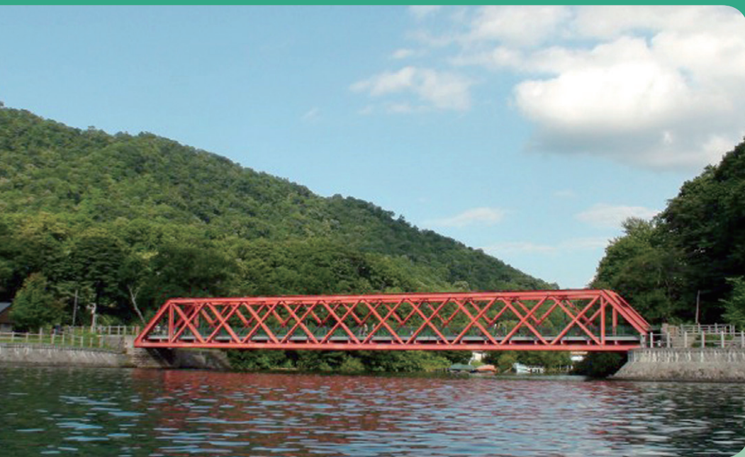
2018 年度選奨土木遺産 山線鉄橋（北海道・明治 32 年竣工）
