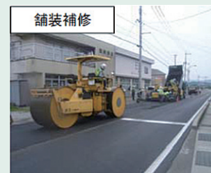
舗装の補修 (切削オーバーレイ工事) (国土交通省資料)
