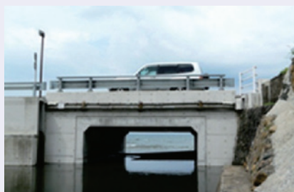
プレキャストボックスカルバートを既設橋の下面に設置した補強
