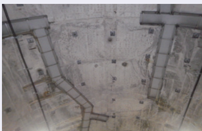
ロックボルトで覆工コンクリートを補強するとともに、漏水の導水を実施
