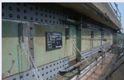
鋼橋の腐食部に当て板して断面欠損部を補強
