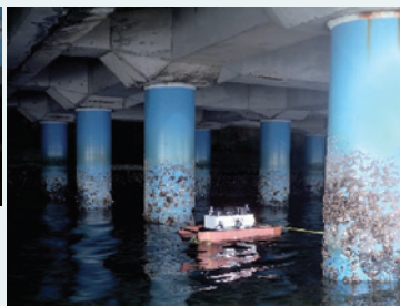
栈橋上部工点検用 ROV を用いた点検診断
