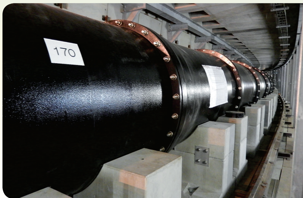
御堂筋共同溝内に設置された水道管路 提供：大阪市水道局
