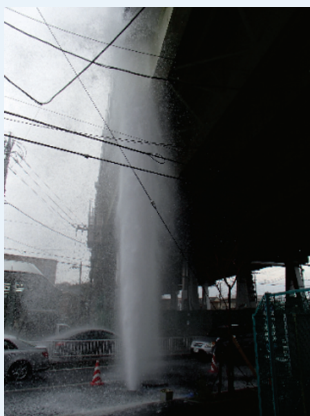
健康度の悪化の事例 腐食等による管路破損の結果、漏水が発生します。
