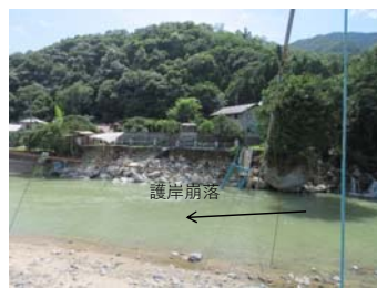
芸備線落橋部の直下流の歩道橋（吊橋）
