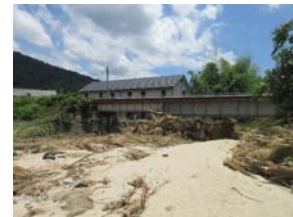
右岸側アパートへの氾濫
