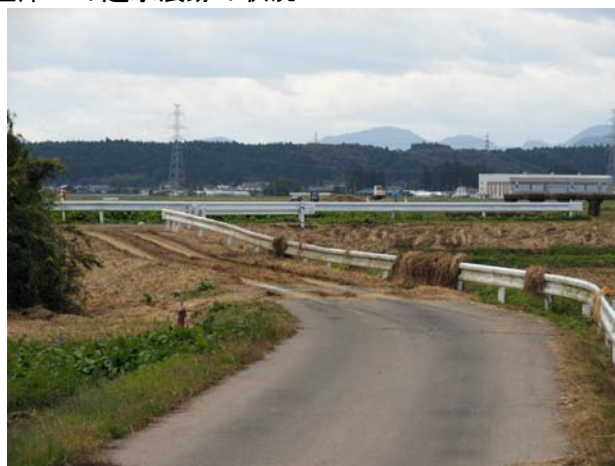
写真 3.3.19 名蓋川から水路を見たところ
