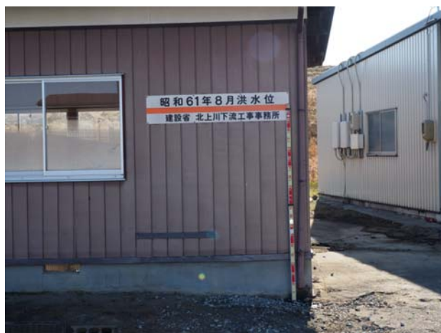
写真 3.3.4 粕川地区内の昭和 61 年洪水水位(浸水深約 2.0m)と今次洪水の浸水痕跡(浸水深約 1.7m)
