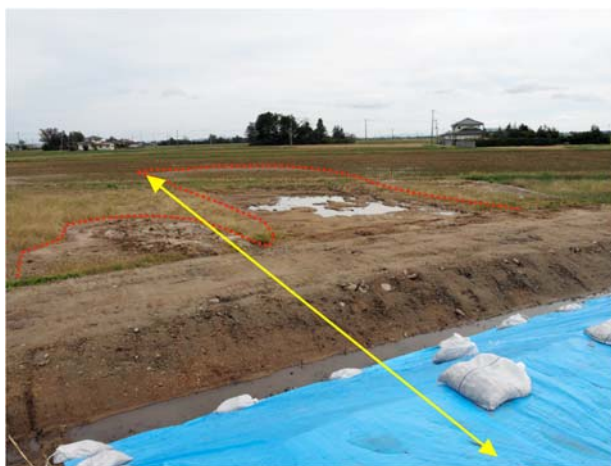
写真 3.3.16 破堤箇所から堤内農地への土砂の拡がり
