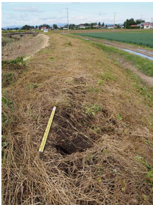
写真 3.3.15 破堤地点直上流部に見られた噴出跡と考えられる箇所
