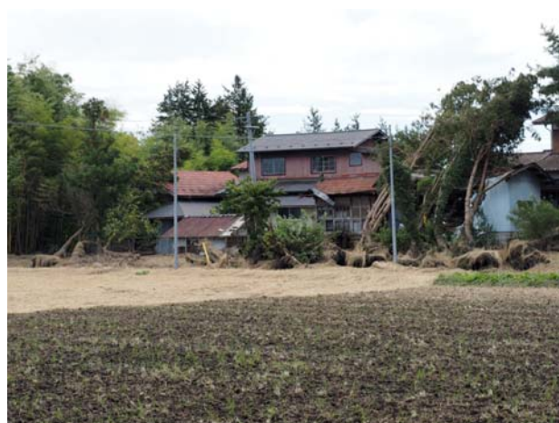
写真 3.3.17 破堤地点の左岸への越水痕跡の状況
