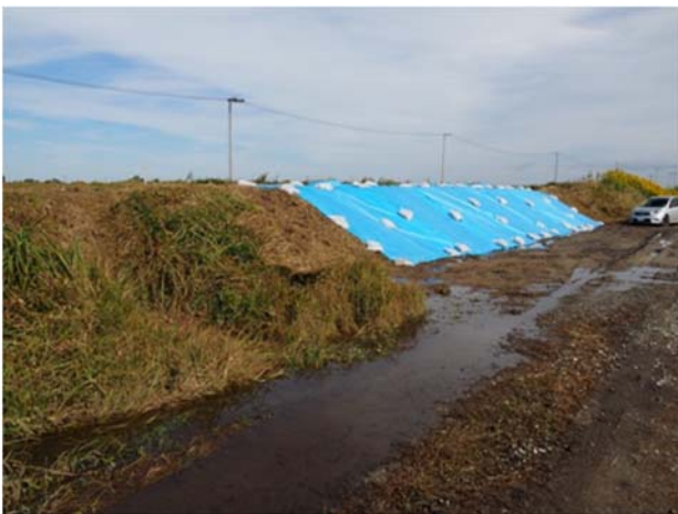
写真 3.3.21 破堤部の上流側での越水痕跡(左:直上流, 右:破堤の数十 m 上流)
