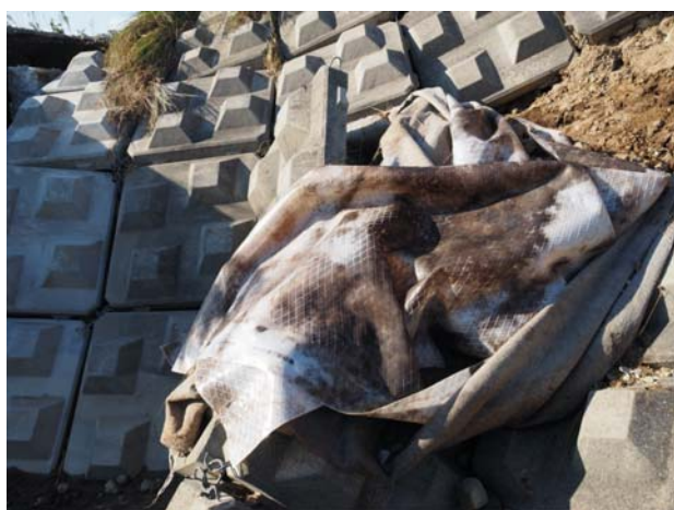
写真 3.3.2 損壊した堤防の状況(左:護岸したの遮水シート, 右:層状の土質状況)
