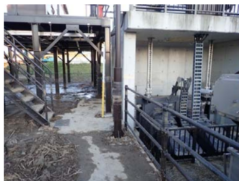
写真 4.2.12 本宮第 1 樋管の水門 (撮影点: N37.510413, E140.400532)
