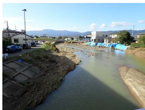
写真 4.2.4 梁川町塩野川橋付近の被害 (撮影点: N37.806123, E140.943556)
