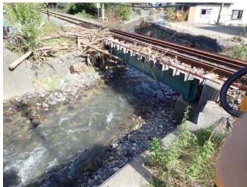
写真 2.3.6 三陸鉄道の鉄道橋
