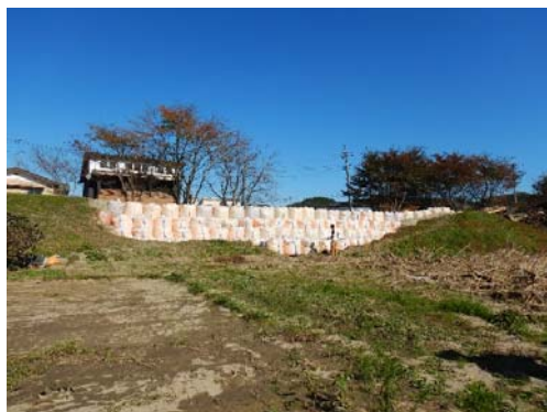
写真 4.4.29 堤防決壊全景
