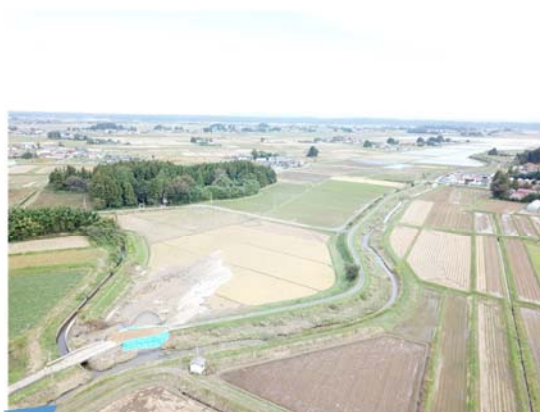
写真 3.2.1 熊谷川破堤地点空中写真
