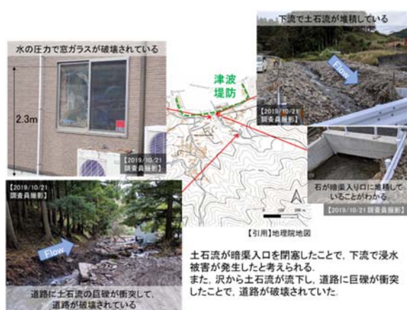
図 2.3.27 尾崎白浜地区での被害状況図
