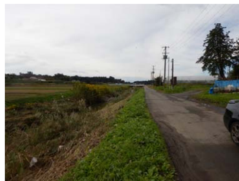
写真 3.2.3 熊谷川破堤地点から上流
