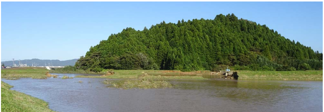
图3.4.12 堤防決壊箇所 (内川, Pt. 5, Pt. 6, 2019年10月13日)
