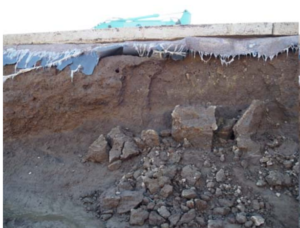
写真 3.3.2 損壊した堤防の状況(左:護岸したの遮水シート, 右:層状の土質状況)
