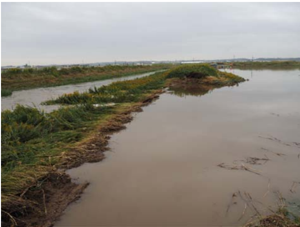
写真 3.3.8(左) 破堤部を上流側堤体上から眺める(10月14日正午過ぎ)
