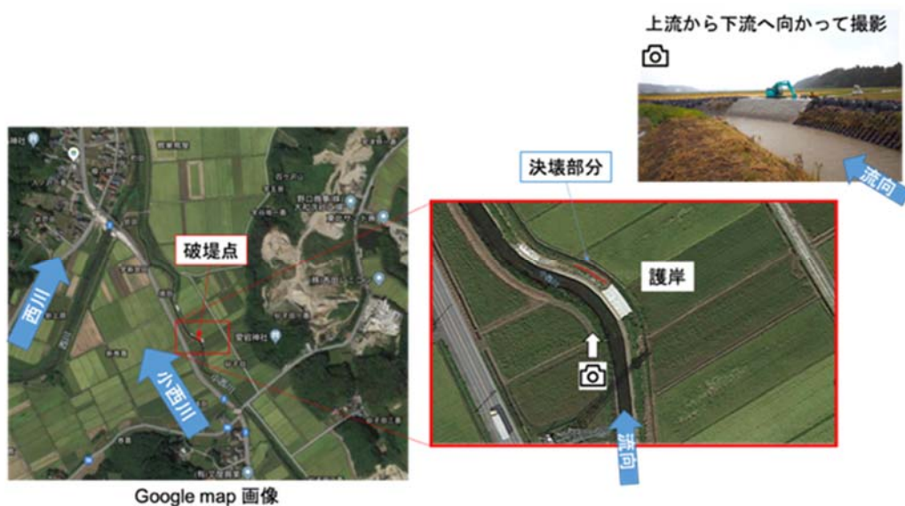
図 3.3.9 小西川決壊地点の様子(左: 西川合流点と決壊地点の位置関係, 赤枠: 護岸と決壊地点の位置関係, 右上: 決壊地点の様子)。
