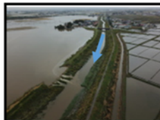
渋井川破堤: H27 左岸。R1右岸
