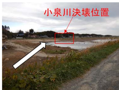
写真 4.4.9 宇多川決壊箇所からの遠景
