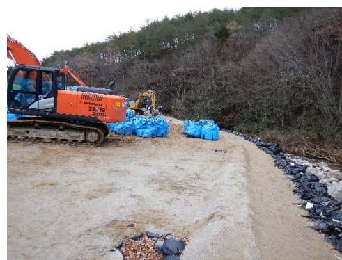
写真 4.4.41 仮置き場の応急復旧
