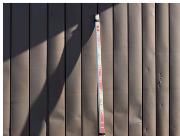
写真 3.3.4 粕川地区内の昭和 61 年洪水水位(浸水深約 2.0m)と今次洪水の浸水痕跡(浸水深約 1.7m)
