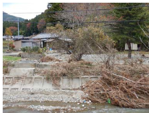
写真 4.4.14 堤防決壊地点付近の流木
