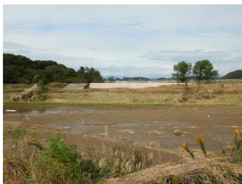
写真 4.3.12 復旧堤防対岸の決壊
