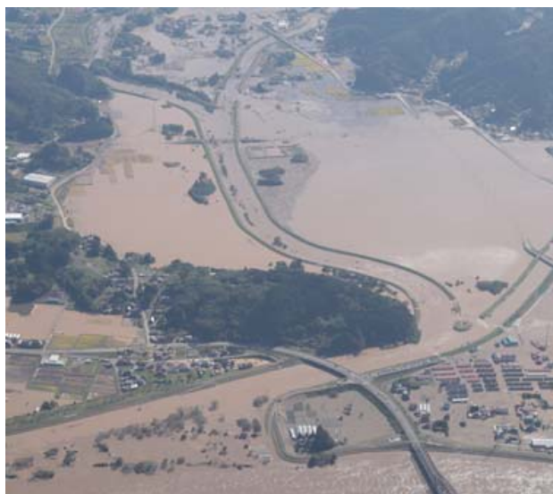
図3.4.14 内川・五福谷川合流部での破堤 Br-1, Br-2 (2019年10月13日13:40)
