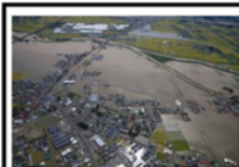
渋井川破堤: 左岸。
