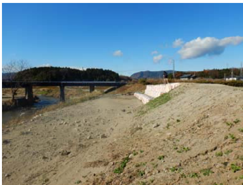
写真 4.4.37 堤防決壊全景
