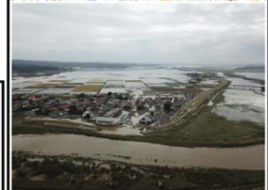
吉田川破堤: 土地の関係で 特殊堤。堤防高さが低い。 河道もやや狭窄
