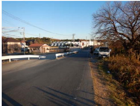
写真 4.4.36 直上の橋梁部付近
