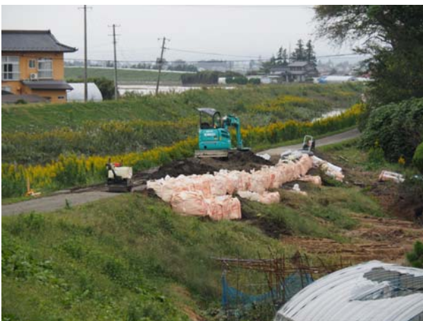
写真 3.3.10(左) 越流部における応急復旧(10月14日)
