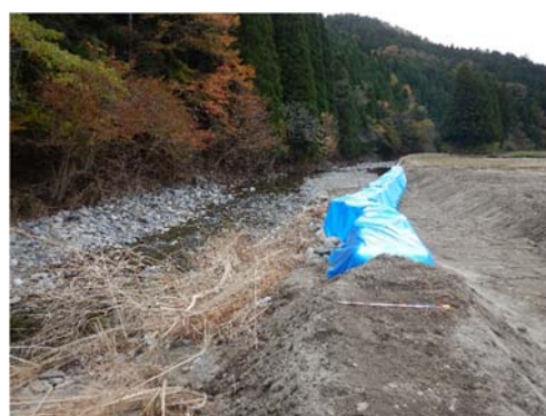
写真 4.4.12 上真野川の決壊箇所
