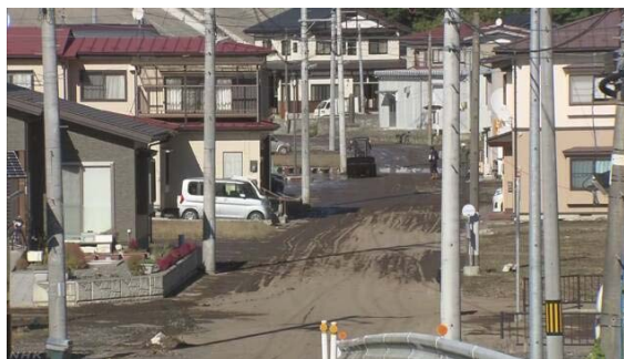
写真2.3.1 小本地区の浸水被害状況 14)
