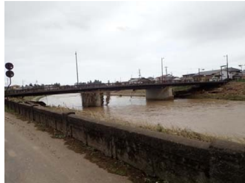
写真 4.4.3 宇多川橋 (撮影点: N40.000000, E140.000000)
