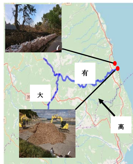
図 2.2.2 有家川の被害状況
