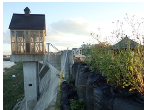
写真 4.2.11 本宮第1樋管 (撮影点: N37.510425, E140.400940)
