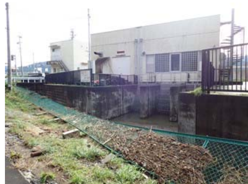
写真 2.3.3 大森川救急内水排水機場
