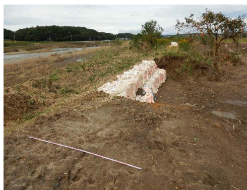
写真 4.3.13 川裏側の樹木の決壊抑制
