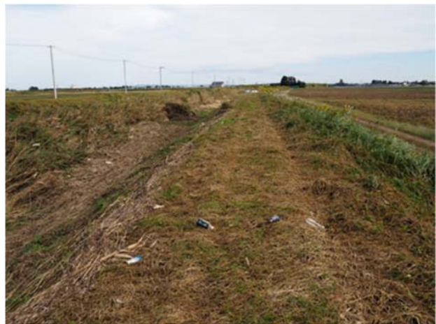
写真 3.3.21 破堤部の上流側での越水痕跡(左:直上流, 右:破堤の数十 m 上流)
