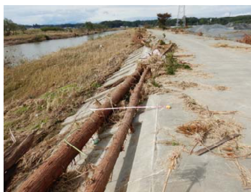
写真 4.3.11 平成 23 年災害時の復旧堤防
