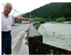
堤防を約0.3m越流 (水位T.P.13.3m)
