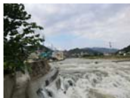
根谷川での護岸の崩壊
