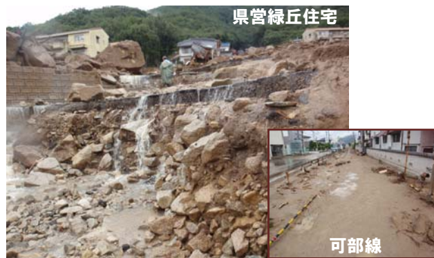
③八木3丁目 県営緑丘住宅。阿武山の標高約350m付近から流下した土石流 が下流の住宅地を直撃した。4mを越す巨岩も流下している。 流下距離が長く、可部線の線路まで土砂が到達していた。県営住宅から上の住 宅は土石流に流されて消滅しており、被害甚大。(花崗岩, 真砂。粘土化した真砂 もみられる。)
