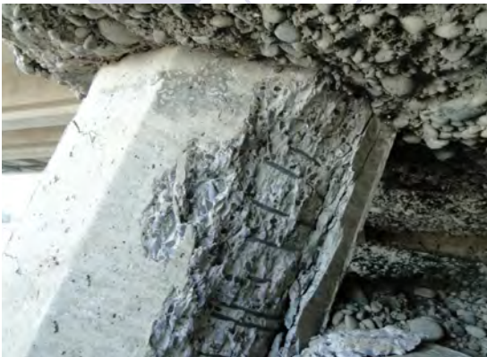
橋台前面側の杭体
