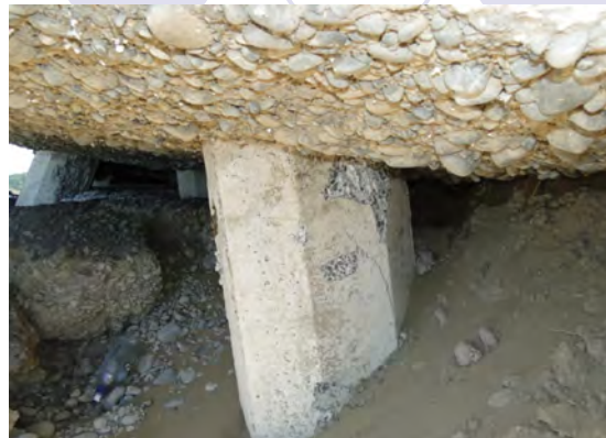
橋台背面側の杭体
