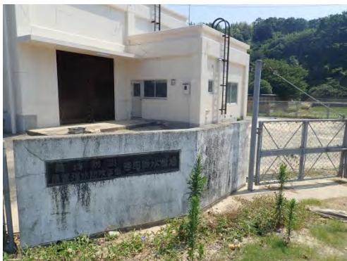
写真⑬(吉田排水機場)
