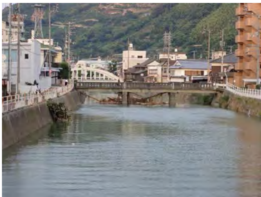
写真07(下流から見たはまだ橋)
