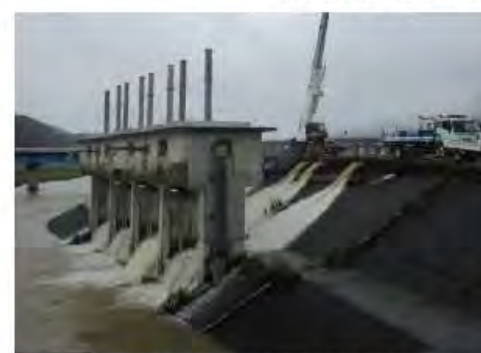
都谷川排水樋門付近(稼動状況)
