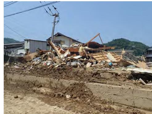
写真⑨(家屋崩壊)
