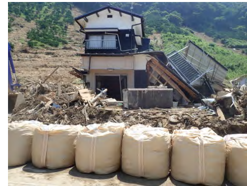
写真⑫(家屋崩壊)
