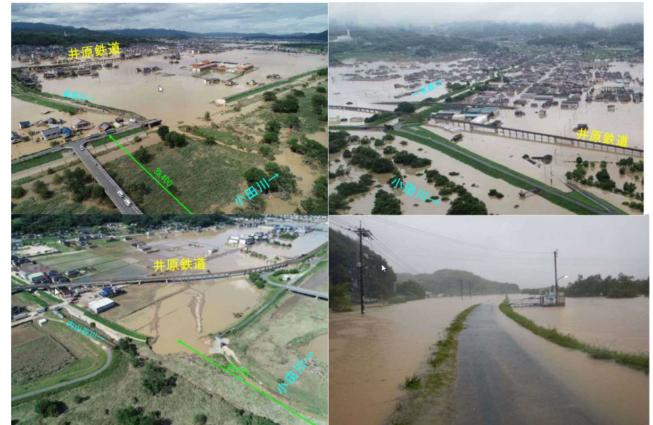
7月8日（日）撮影 左岸6k400付近堤内地
