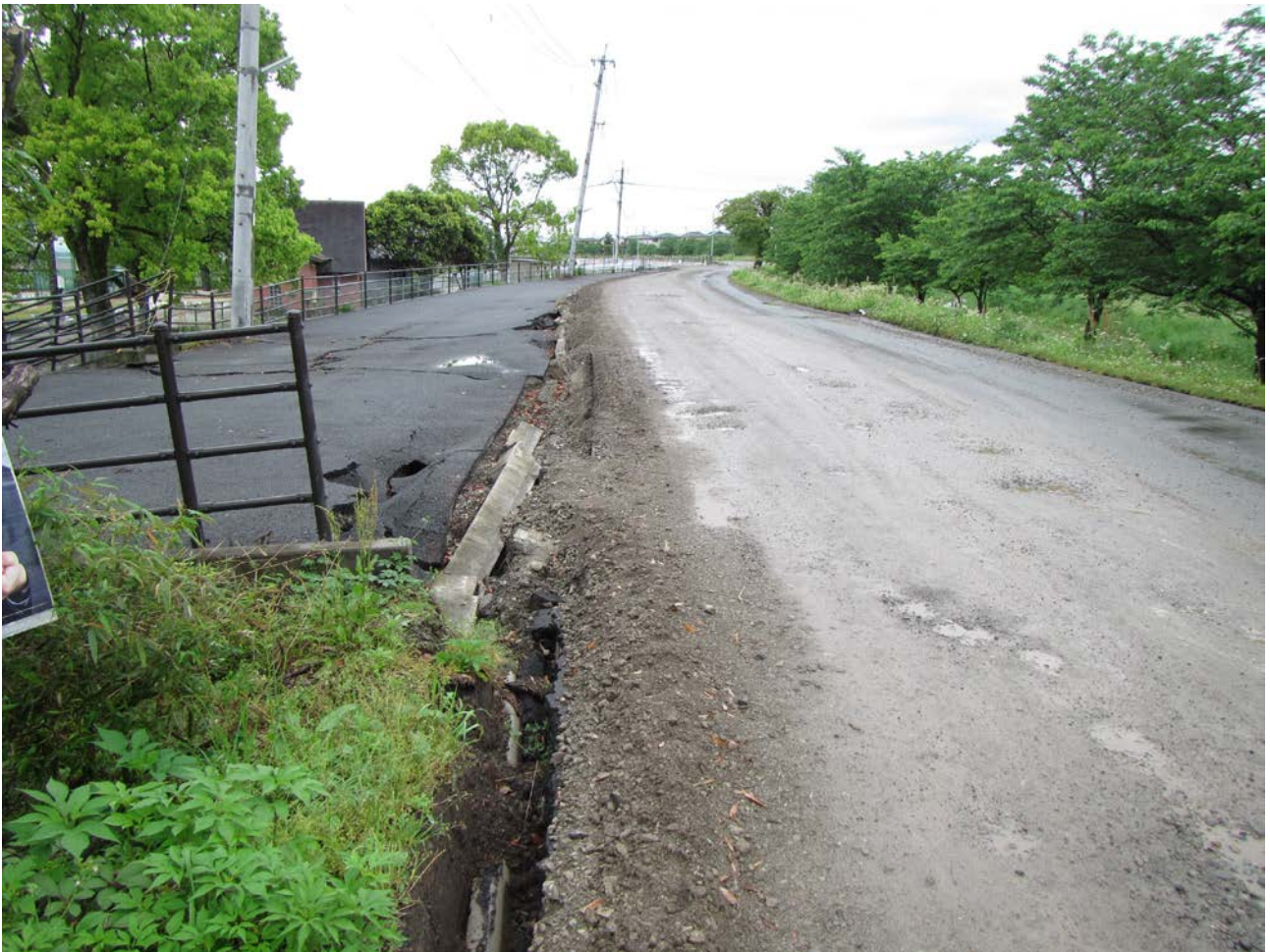
秋津川左岸側の堤防道路。堤防裏側に変位した模様。元々道路はアスファルト舗装されていたが、視察当時はアスファルトが無かった。
