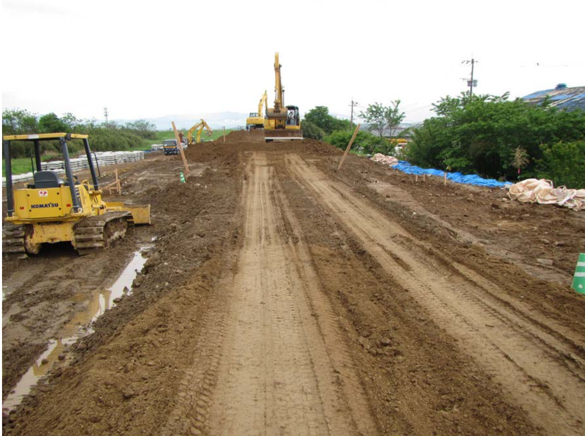
こちらにも既に重機が入って、表のり，天端，裏のり面の工事中.
