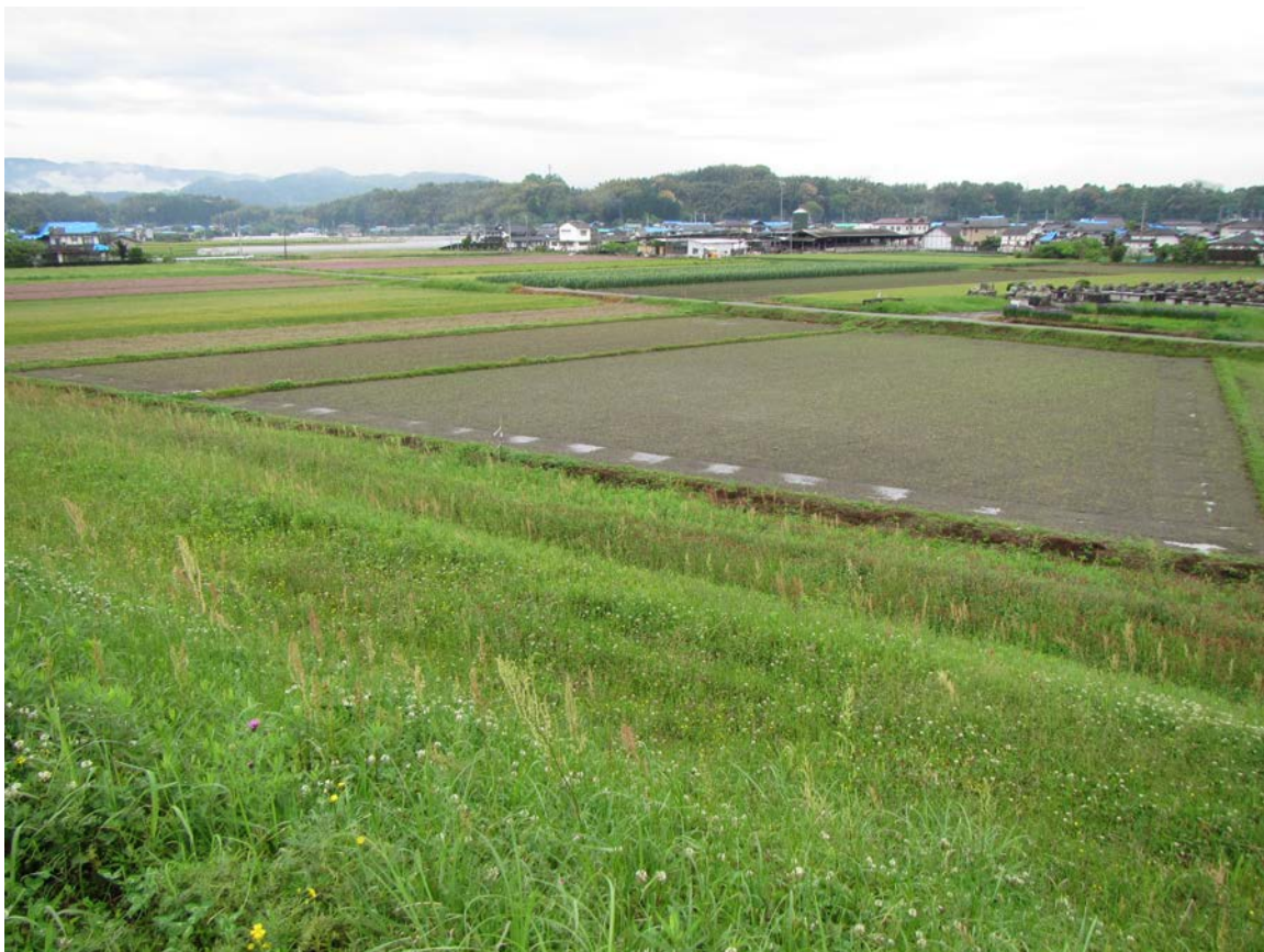
被災箇所傍の裏のり面側．畑地内に一定間隔の水たまりあり．
