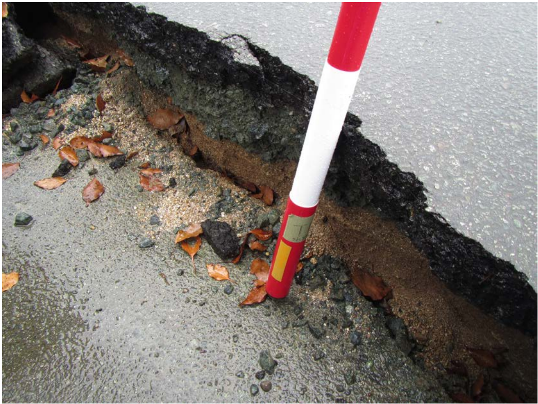
路盤材の下は礫混じり砂.
