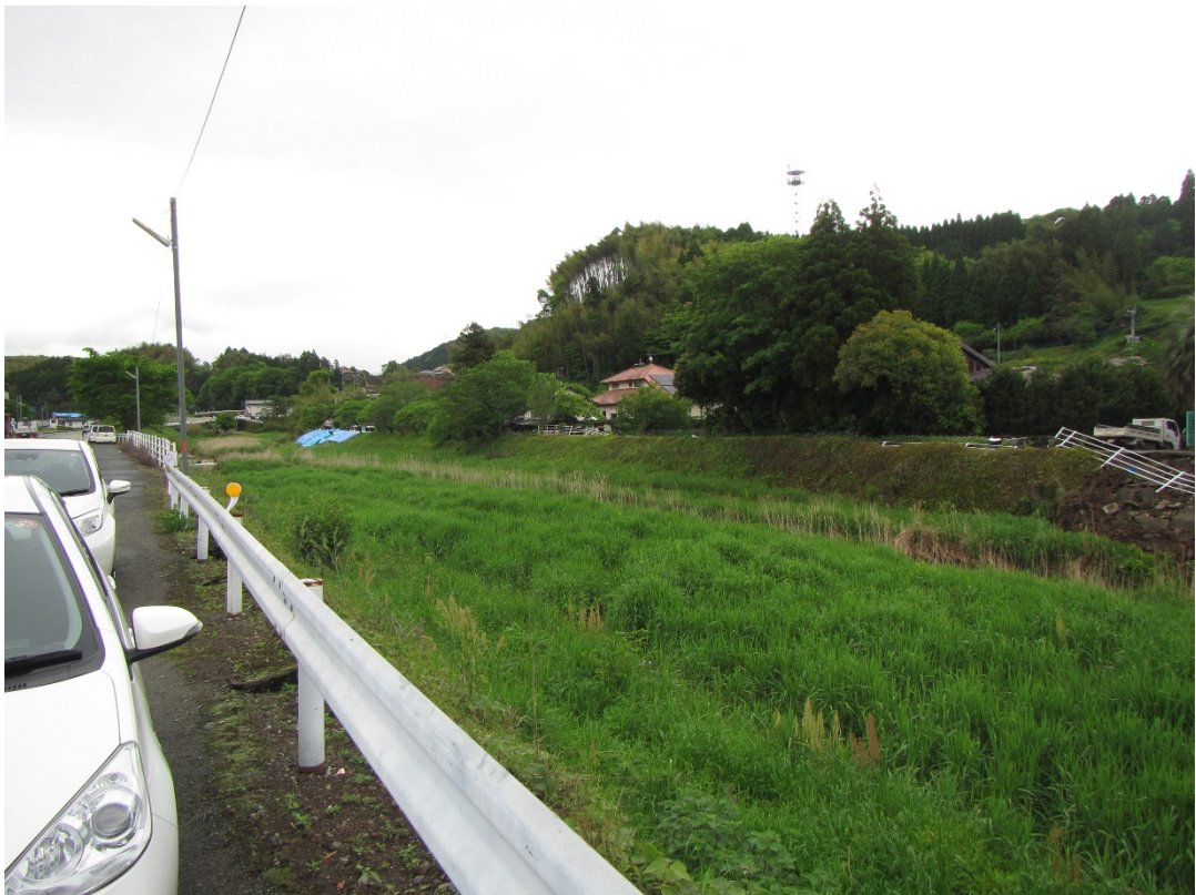
崩落現場の上流 100m 地点にもブルーシート．同じく護岸崩落が起きたか？
