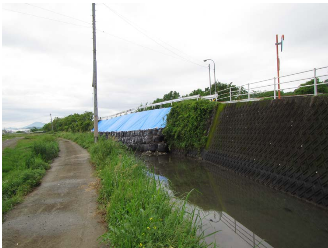
同じ場所を裏のり面側から撮影. のり尻に小水路あり. のり尻に土嚢が 3 段積まれていた.
