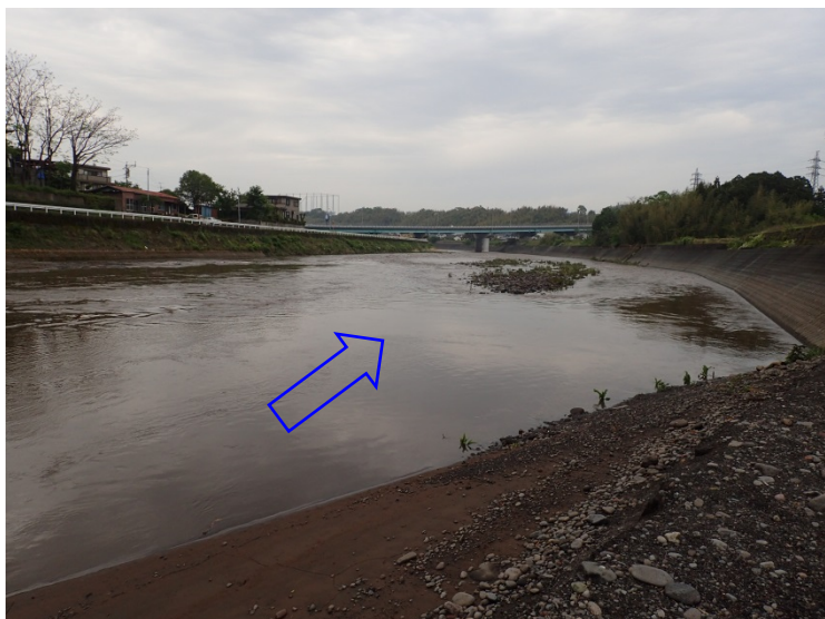
2.弓削(近くの弓削神社の鳥居が破損)
