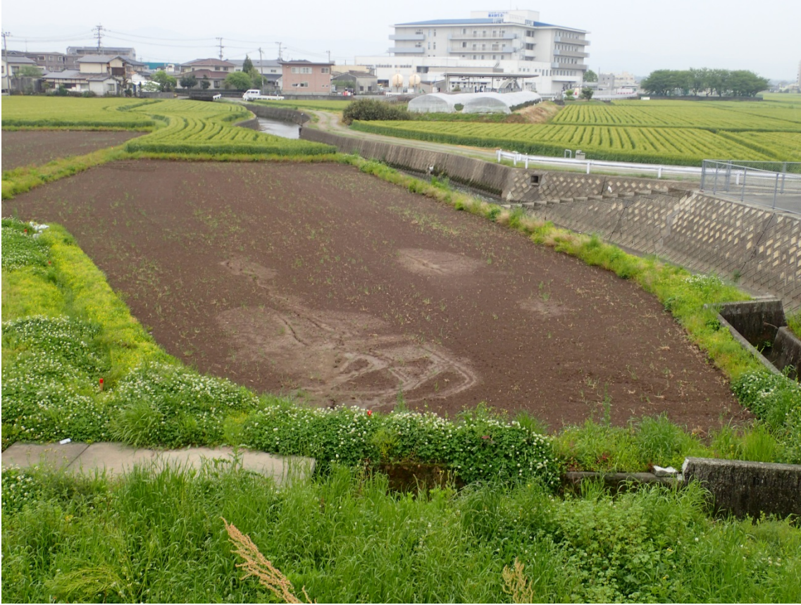
堤内地側：憤砂跡？
