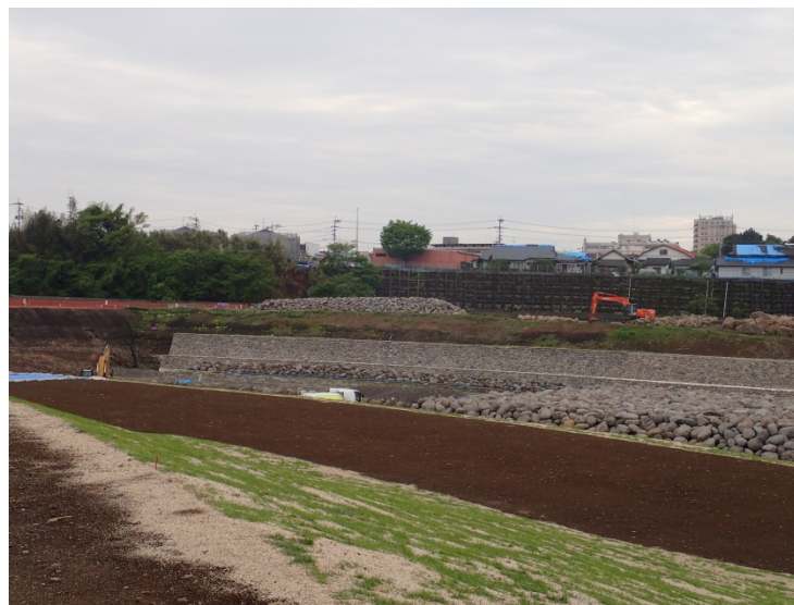
3.龍田陣内(九州北部豪雨の改修工事中)
