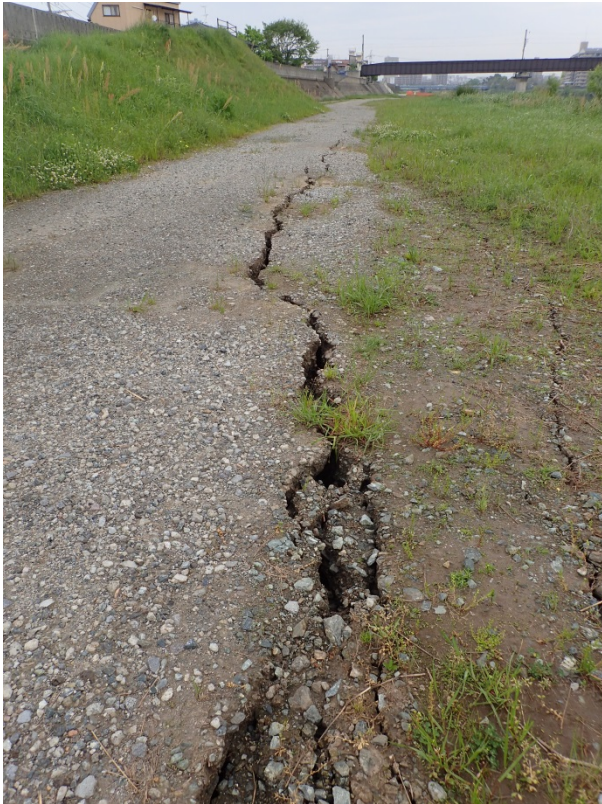
川表側: 高水敷に縦断方向の亀裂
