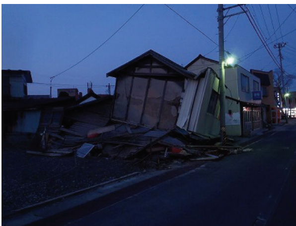
写真 8-4 地震動により全壊した家屋。一階部分が崩壊した (図 8-1: 133)
