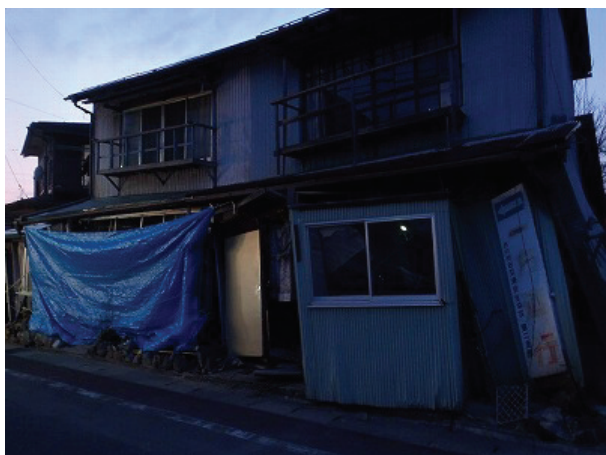
写真 8-3 地震動により大規模半壊となった家屋(図 8-1: 132)
