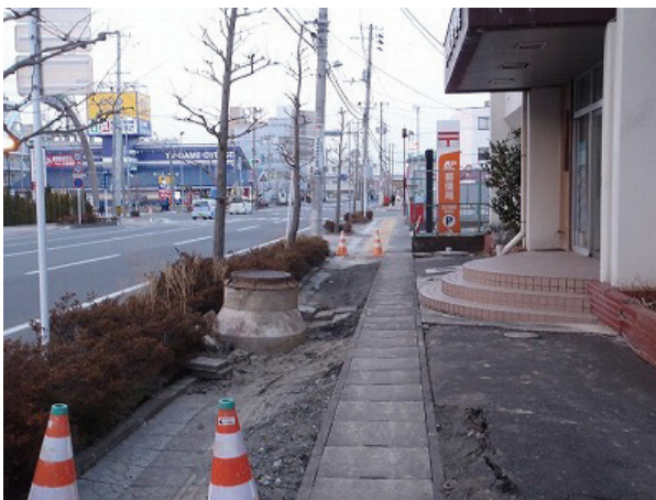
写真 8-2 古川駅周辺における今回の調査で最も高く浮上したマンホール。70 cm 程度浮き上がる (図 8-1: 127)
