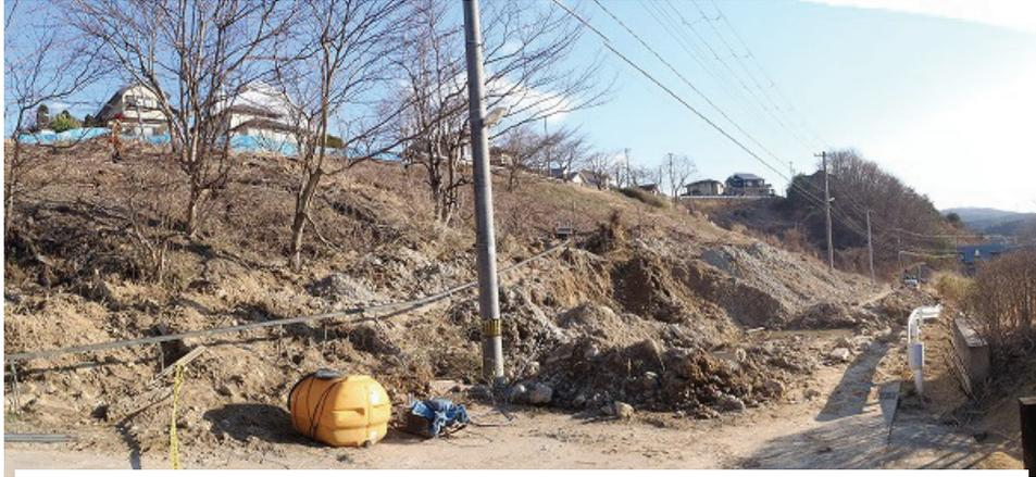
写真 6.7-1 北中山造成地の崩壊の様子 (図 6.7-2: 088)
