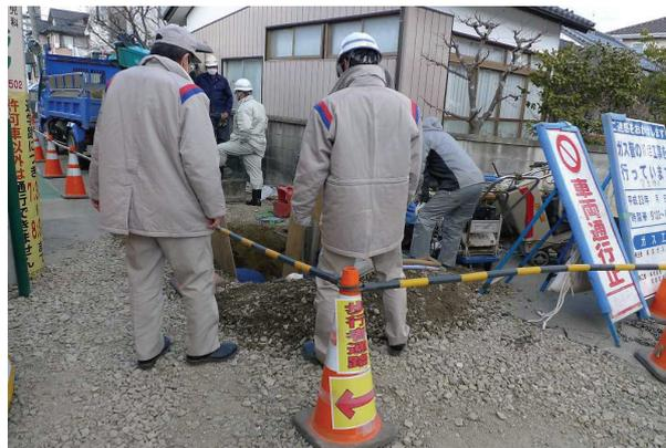
写真6.9-6 旭が丘2-34と2-28の間の道路におけるガス導管補修工事（3月28日撮影）（写真6.9-1: 240）
