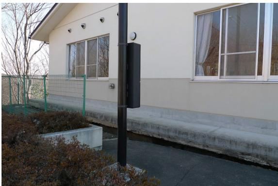
写真6.3-1 名取市相互台児童センター西側の基礎周囲の地盤沈下（写真奥が斜面）
