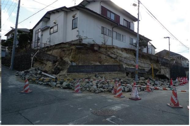
写真6.9-3 旭が丘2-13-21における擁壁の崩壊（写真6.9-1: 228）
