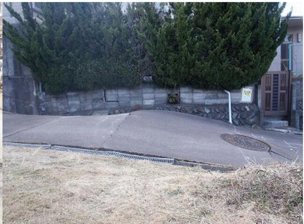
写真 6.4-14 崩壊ブロック下部に生じた隆起 (図 6.4-6: 058)
