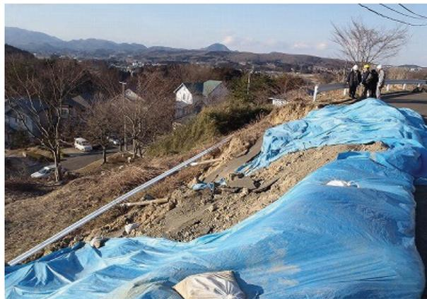
写真 6.7-2 崩壊した造成地の周縁道路 (図 6.7-2: 097)
