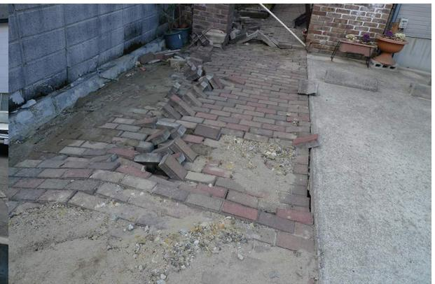
写真6.9-5 旭が丘2-34-33における宅地アプローチの変状（写真右側が北で地盤が低くなっている）（写真6.9-1: 235）
