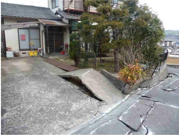
写真6.5-12 折立5-5-13の被害（写真6.5-11の道路を挟んで北側の宅地，図6.5-1: 430）
