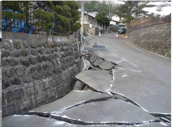
写真6.5-15 折立5-9と5-10の間の道路と擁壁の被害（図6.5-1: 422）
