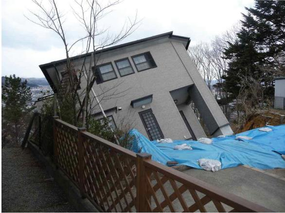
写真6.6-2 斜面崩壊により崖下に転落しかかった西花苑2-22-8の家屋
