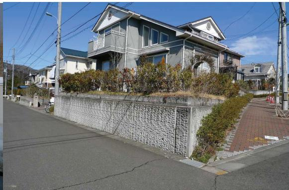
写真6.3-2 名取市相互台3-11の不同沈下した宅地（写真手前と奥の2軒）
