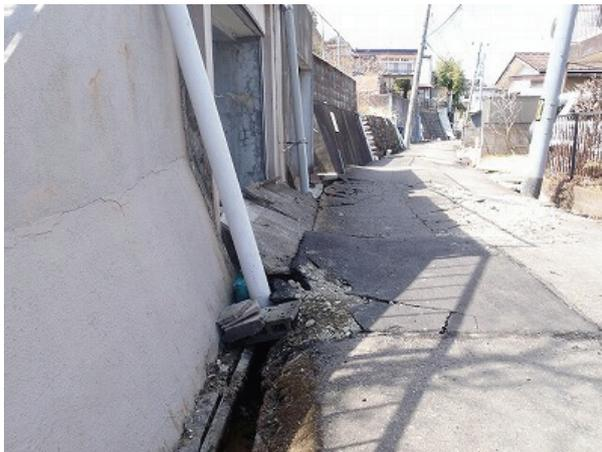
写真 6.4-13 崩壊ブロックの中腹部における被害の様子 (図 6.4-6: 051)
