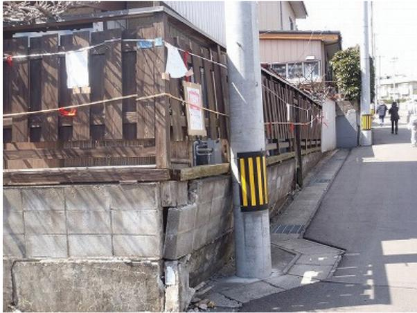
写真 6.4-15 崩壊ブロック下部におけるブロック積み擁壁の変状 (図 6.4-6: 047)
