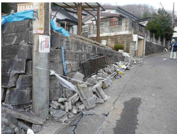
写真6.5-16 折立5-9-18の北側の道路に沿った擁壁の被害（図6.5-1: 423）
