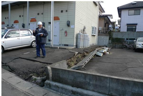
写真6.9-4 旭が丘2-12の北端における擁壁の倒壊（写真6.9-1: 231）
