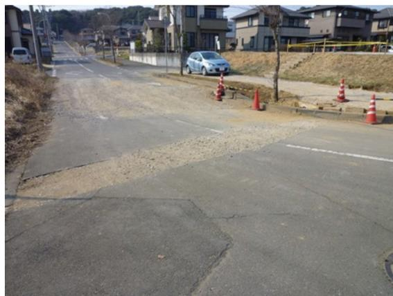
写真 10.6-48 斜面底部では液状化被害
