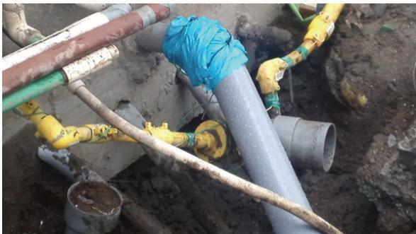
写真 10.7-14 建物周辺の沈下により変形している
