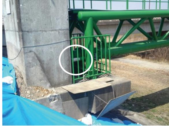
写真 10.3-18 河川横断部片側に設置されているダンパー
