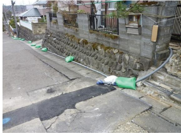
写真 10.4-6 2層 PP 管による仮設配管
