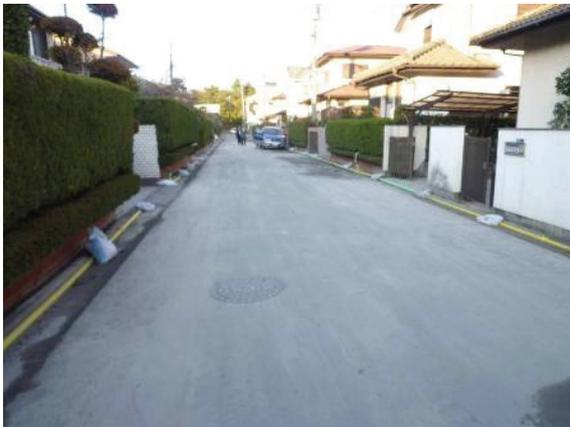
写真 10.7-6 地上仮設ガス配管 (PE 管) 美浜
