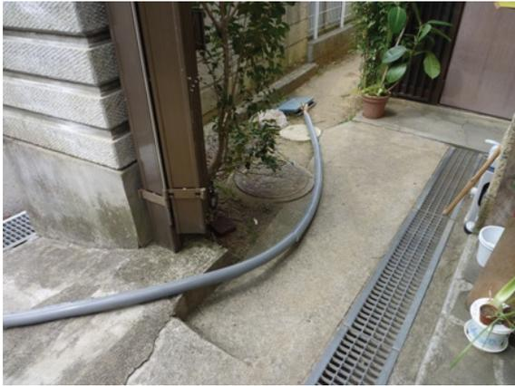
写真 10.4-5 2層 PP 管による仮設宅地内配管
