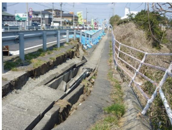
写真 10.6-64 日立製作所前の国道の法片崩壊
