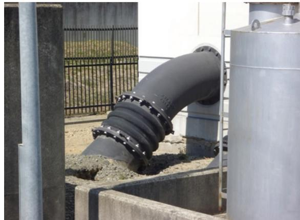
写真 10.4-39 排水管路の周辺地盤の沈下
