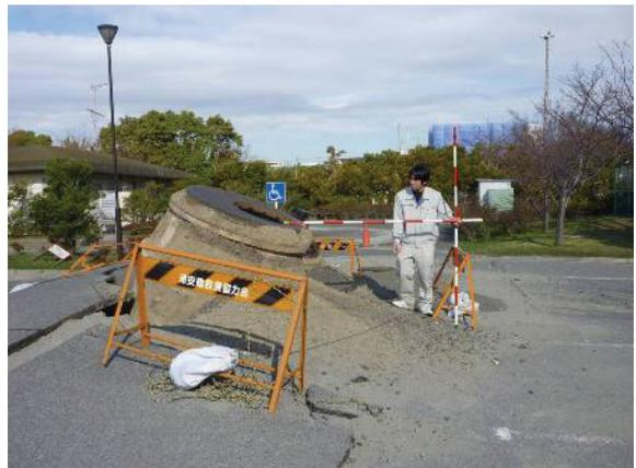
写真 10.7-11 耐震性貯水槽 100<sup>3</sup>の浮上
