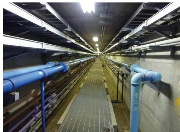
写真 10.5-13 工水側共同溝の内部
