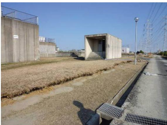
写真 10.5-12 工水側共同溝周辺地盤の沈下
