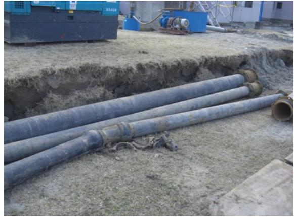
写真 10.5-3 撤去された管路 DIP(T形)
