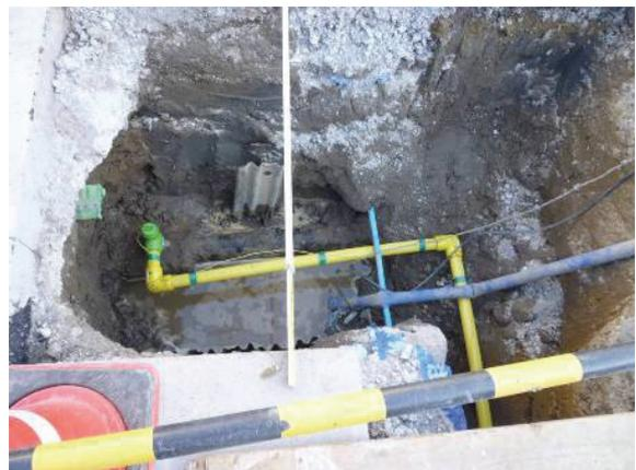
写真 10.7-5 ガス管の本管復旧 (PE 管) 美浜
