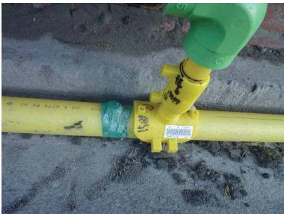
写真 10.7-4 地上仮設ガス配管 (PE 管) 美浜
