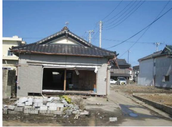
写真 10.7-30 飯岡海岸の住宅の津波被害
