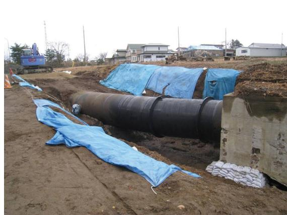
写真 10.3-3 伏せ越し上流側の管路 (復旧後)
