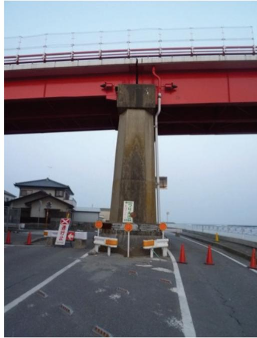
写真 10.6-53 海門橋の基礎で液状化
