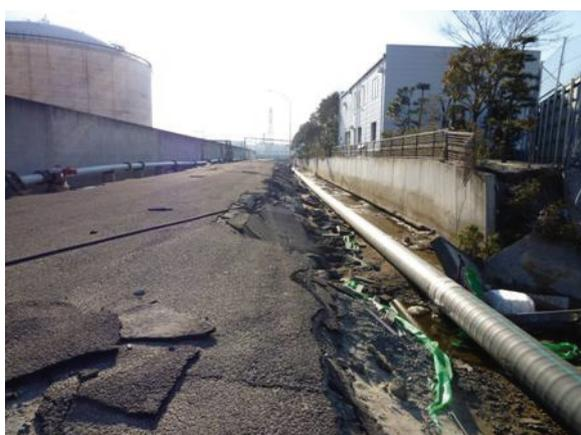
写真 10.4-25 露出した地中ガス鋼管
