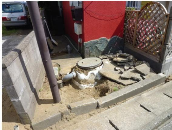
写真 10.7-26 浄化槽の浮上
