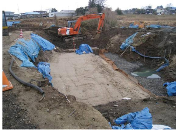
写真 10.3-4 伏せ越しコンクリート巻きたて部
