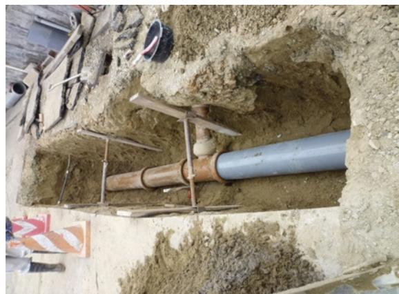
写真 10.4-10 下水管 (陶管φ250) の復旧
