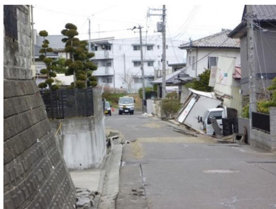
写真 10.4-4 斜面に沿って変形した道路
