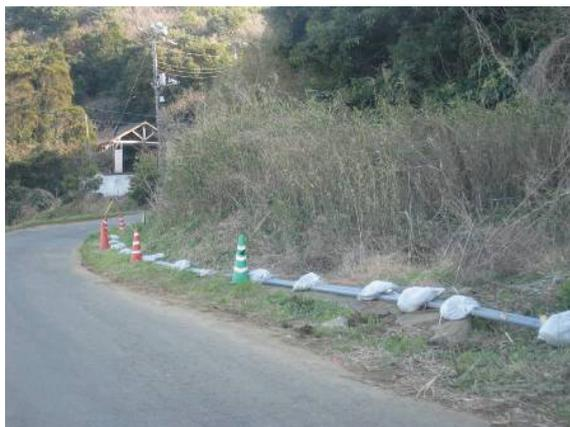
写真 10.7-35 仮設配管 (VP  $\phi$  75, 2 条)
