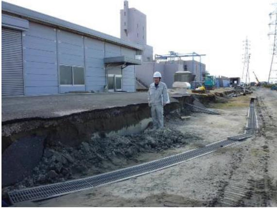
写真 10.5-2 上水施設側の共同溝の浮上
