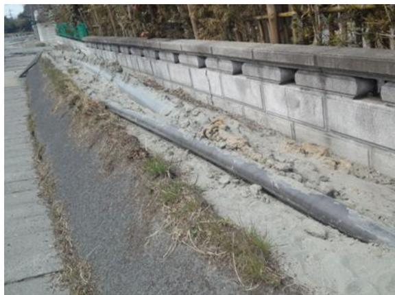
写真 10.6-37 下水管上を交差する水道管
