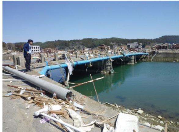
写真 10.4-35 南三陸町八幡川最下流の橋の添架管
