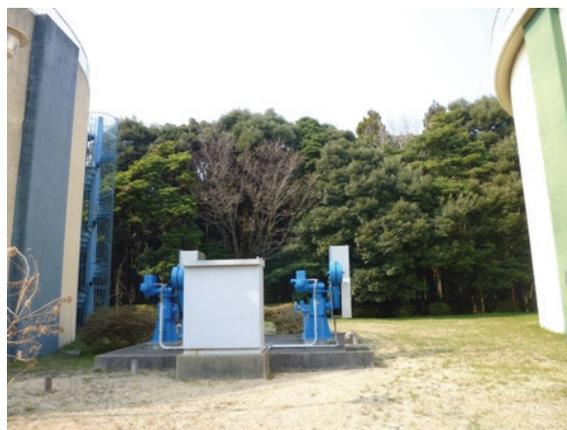
写真 10.6-25 緊急遮断弁 2 基
