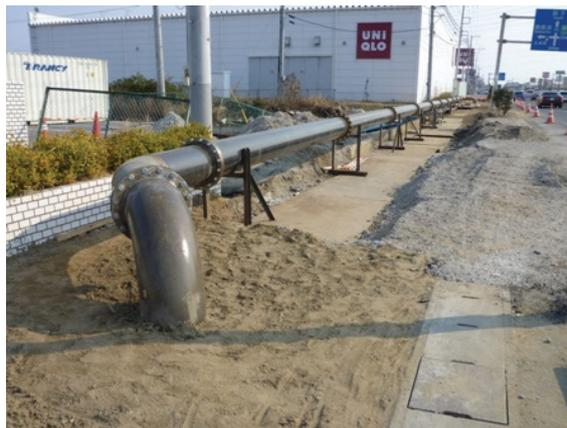
写真 10.6-15 国道 124 号線の県水送水管復旧
