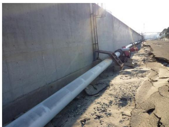
写真 10.4-26 丘架けされていた用水管路
