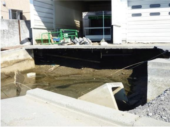
写真 10.4-32 洗掘による管路の抜け
