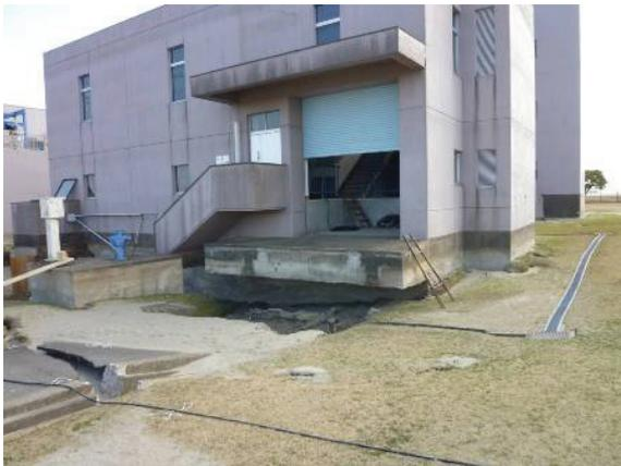
写真 10.5-4 ポンプ室前の地盤沈下
