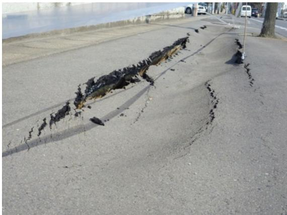
写真 10.6-59 下水道管路上の地盤沈下
