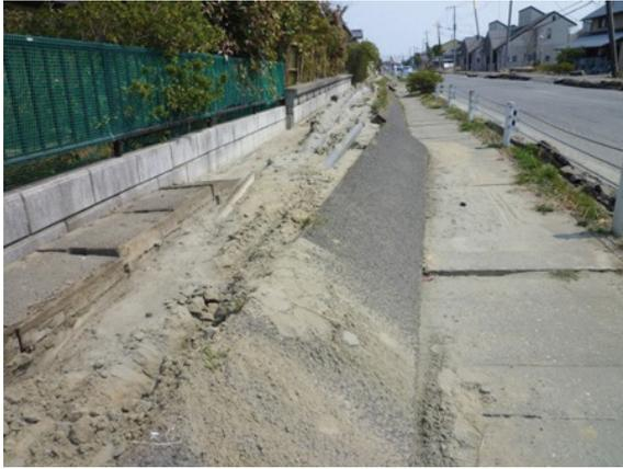
写真 10.6-35 雨水枡横の水道・下水管路の隆起
