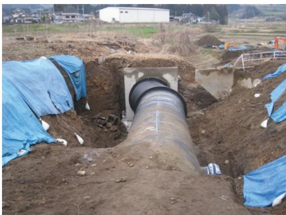
写真 10.3-2 伏せ越し上流側の管路のずれ
