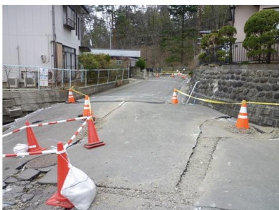
写真 10.4-3 宅地擁壁の移動で盛り上がった路面
