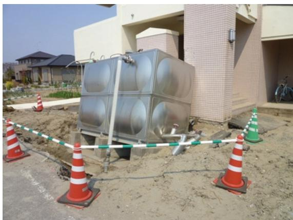
写真 10.6-33 貯水槽の基礎の沈下
