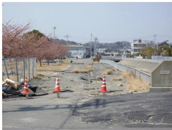
写真 10.6-66 河川右岸の液状化による沈下
