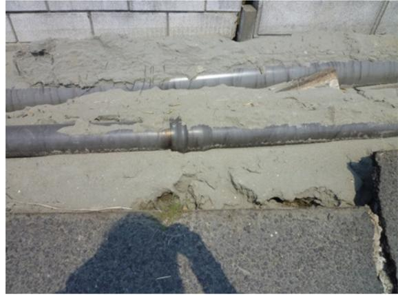
写真 10.6-36 隆起した水道・下水管路
