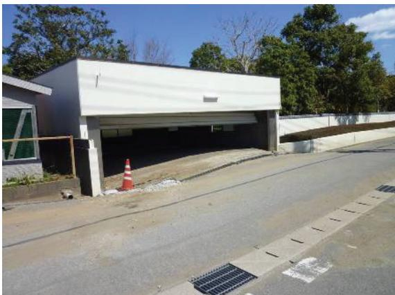
写真 10.7-17 後草地区谷原 沈下するガレージ
