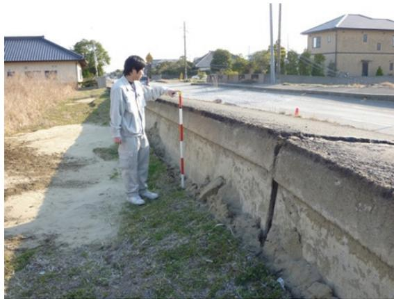
写真 10.6-13 掘割町液状化による雨水枡浮上
