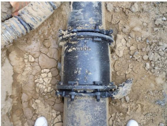
写真 10.6-8 DIP φ 300K 形継輪・復旧後
