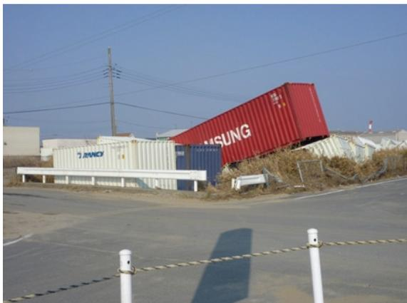
写真 10.6-18 河川橋で堰き止められたコンテナ
