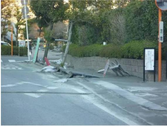
写真 10.7-2 舞浜の液状化
