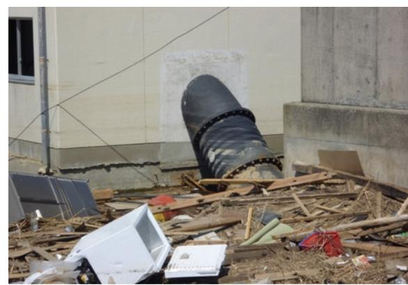
写真 10.4-41 排水管路の周辺地盤の沈下
