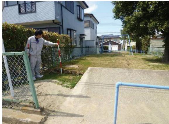
写真 10.7-48 新開町の防火水槽の浮上 20cm
