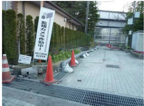
写真 10.7-7 水道管の地上仮設配管 (VP 管) 舞浜
