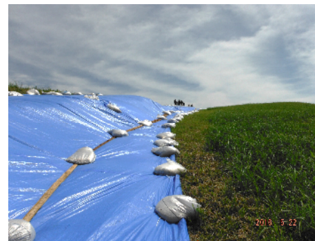
北外輪ミルク ロードの南側斜 面に発生した亀 裂にかけられた ブルーシート (200m以上)
