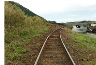
国道57号の山側のJR豊肥線も 線路が押し出されて変形
