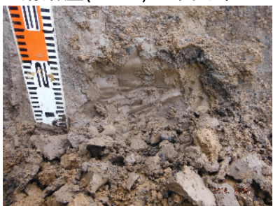
滑落崖底部に見られる軟弱な粘土層(すべり層?)
