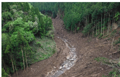
土石流の流下跡(塞き上げ高さ10m程度)
