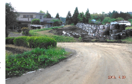
山王谷川の砂防堰堤(右側袖部が流された)
