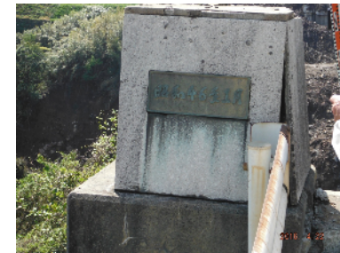
左岸に残る橋梁の銘版 (昭和46年1月)
