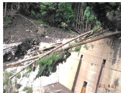
山王谷川の砂防堰堤(右側袖部が流された)
