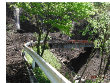
金竜の滝から流れた土石流で橋や付近の道路を埋めている
