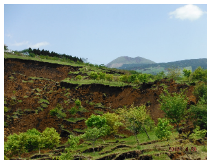
南側に崩落し、 立木の状態で崩 壊地盤が残って いる
