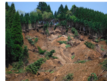
斜面崩壊上端部黒ぼく・赤ぼく層等の表層崩壊
