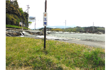
国道57号阿蘇立野病院付近の段差
