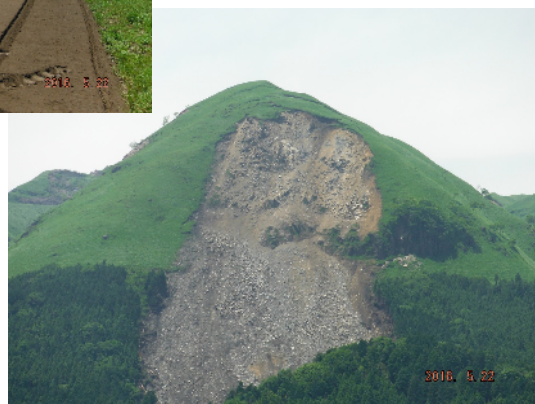
西外輪の斜面崩壊 滑落崖上部に亀裂がみ られる 途中に停止している崩 壊土砂は非常に不安定
