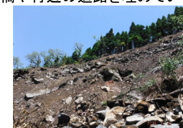
大規模な斜面崩壊の上端を望む
