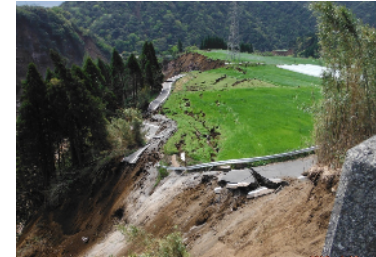
長陽大橋から上流側の斜面滑落と亀裂
