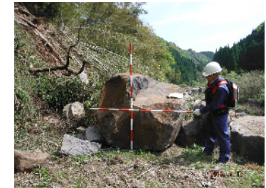
道路下の御船川河川敷まで落下
