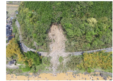
ドローンによる空中写真(提供: 九州地方整備局)
