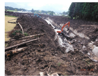
流出土砂の重機による排土作業
