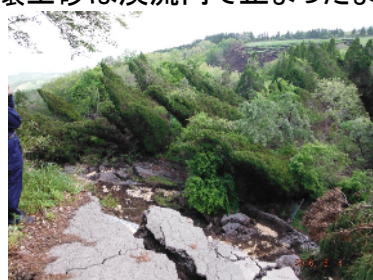
道路が谷底に落下(地獄・池の窪線) 谷底に落下した道路の拡大
