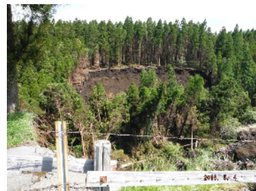
地獄温泉の上流部の斜面崩壊、崩壊土砂は溪流内で止まったまま
