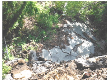
道路が谷底に落下(地獄・池の窪線) 谷底に落下した道路の拡大
