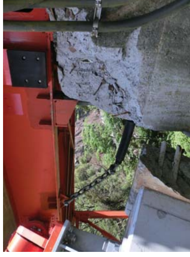
橋軸直角方向の衝突時用緩衝材
