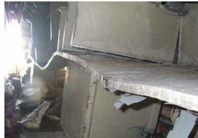
桁の変形
