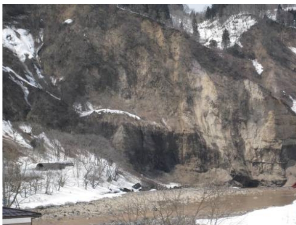
③信濃川の中津川との合流点上流側左岸 河岸段丘斜面の崩落。左下のトンネルはJR飯 山線。
