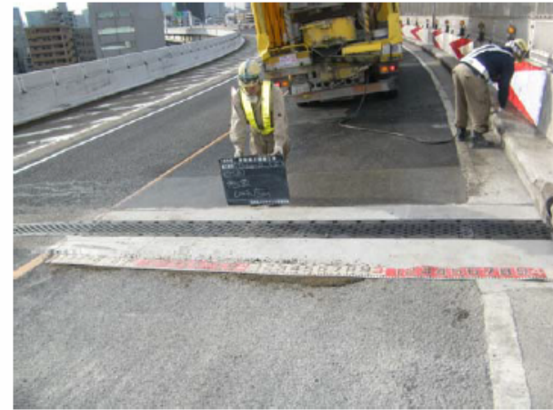
伸縮装置取替
