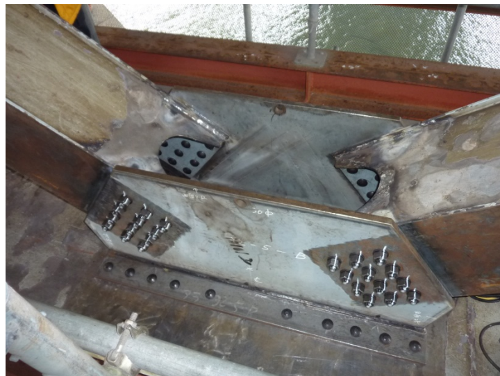
取付部材取替
