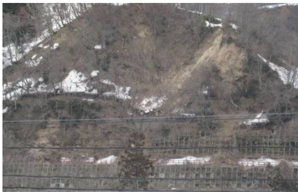
①津南・信濃川左岸 河岸段丘斜面崩落により，雪崩予防柵や法 枠工などが破壊されている。
