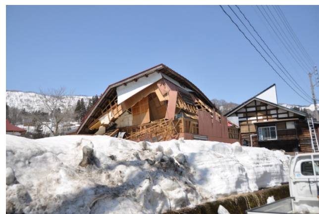
家屋の倒壊は、青倉トンネル～栄大橋地区お よび横倉地区に大規模な破壊がある。
