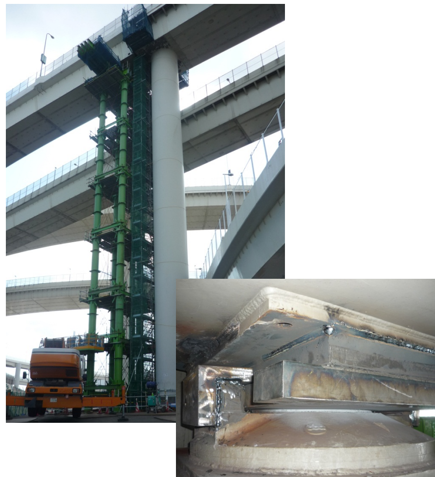
桁橋をベントで支持し、支承を補修
