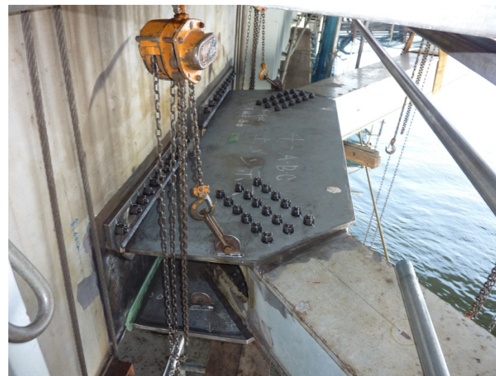
取付部材取替
