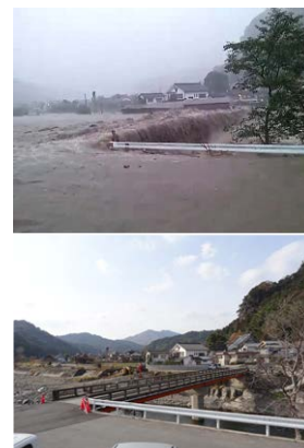
写真 4.1 山国町での橋梁越水
