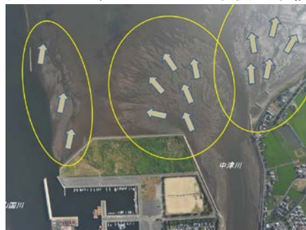
図 4.17 山国川・中津川河口の出水後の土砂堆積
