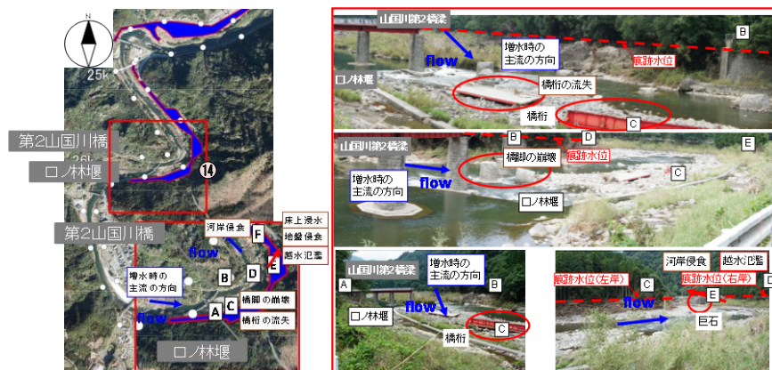
図 4.14 山国川第 2 橋梁周辺の被災状況の概要
