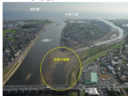
図 4.18 山国川・中津川分岐の出水後の土砂堆積
