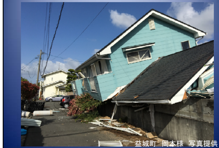
前震後 新耐震 築20年
