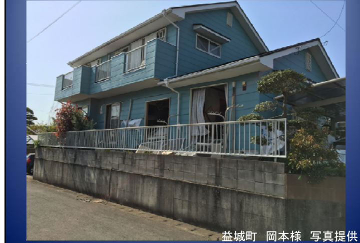
前震後 新耐震 築20年
