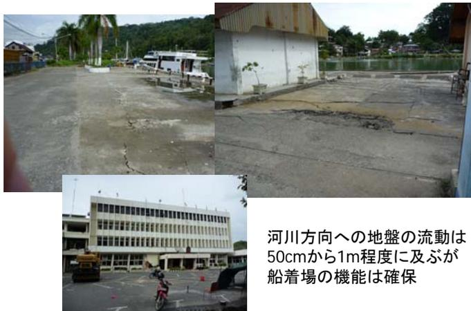
河川方向への地盤の流動は50cmから1m程度に及ぶが船着場の機能は確保
