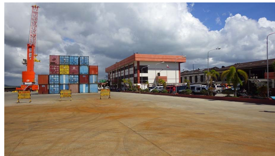
3階建てのコンクリート造の港湾管理施設は, 1階の窓と, 2階の窓が1枚破られるもほぼ無傷
