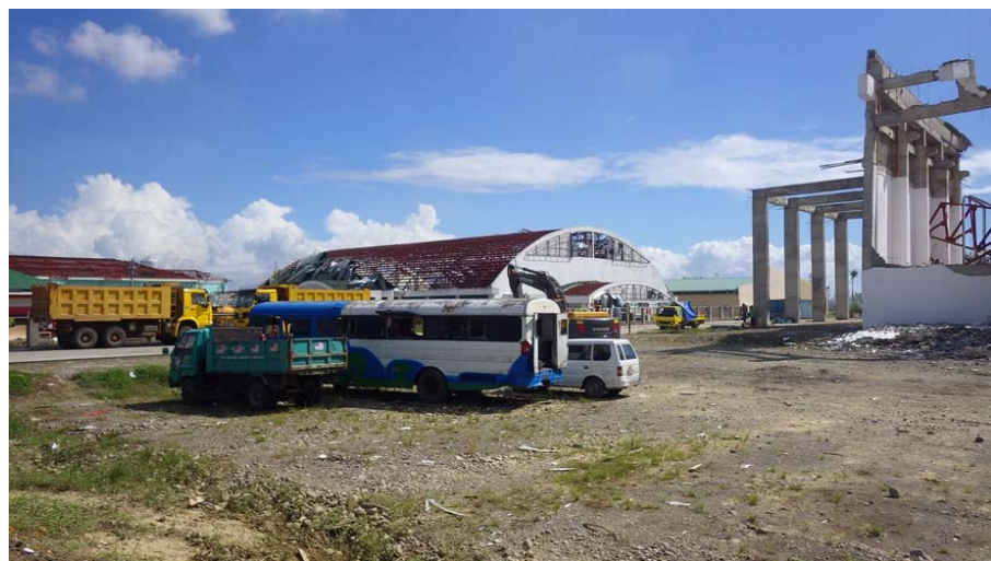
レイテ・コンベンションセンターの周辺の施設も屋根が飛んでいる
