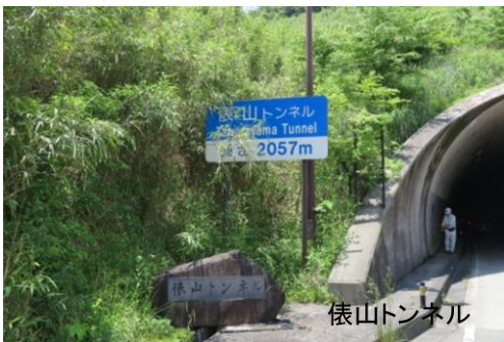
俵山トンネル坑口（南阿蘇村側）
