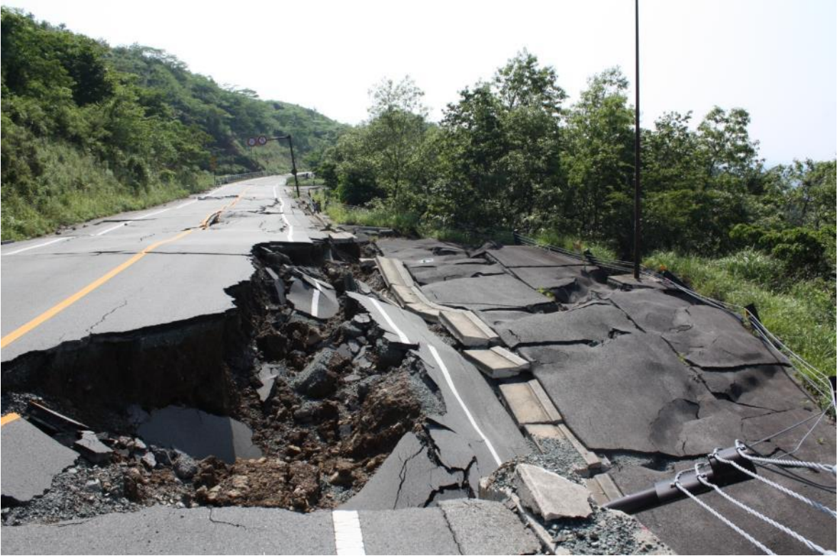
俵山大橋付近
