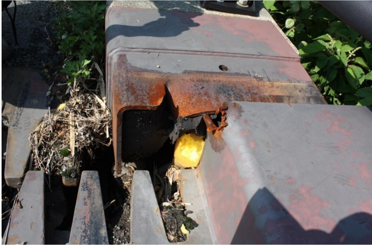
俵山大橋付近
