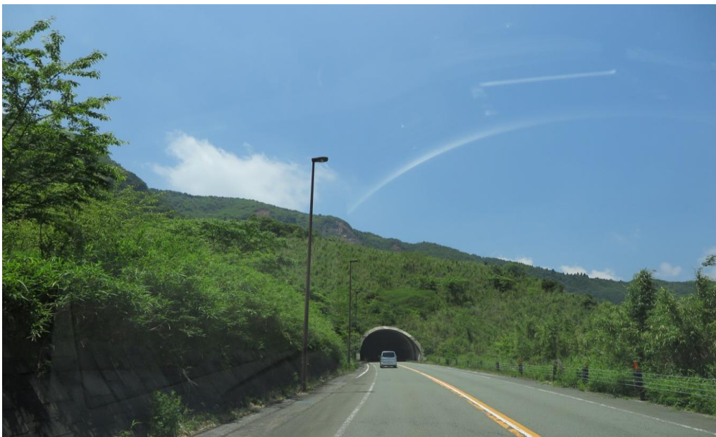
俵山トンネル坑口（南阿蘇村側） （土被りが浅いが、100m 坑内に入ると土被りが急に増えるようである）
