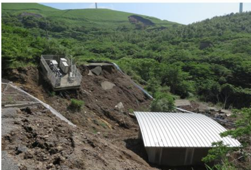
坑口付近の変電施設
