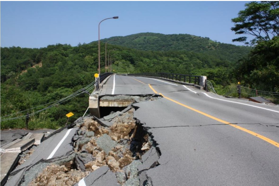
俵山大橋付近
