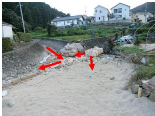
(d) 地点⑥での護岸の破損
