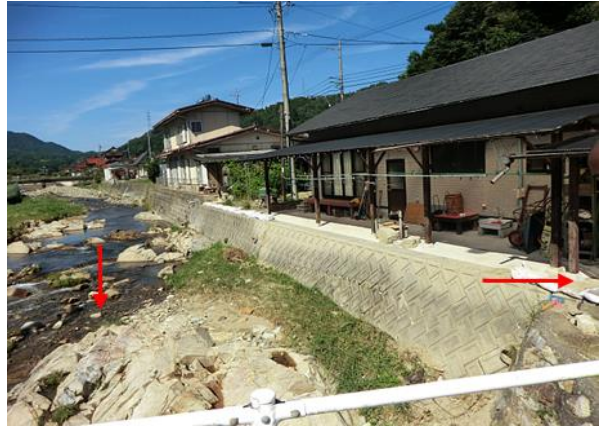
(e) 地点④での護岸の破壊と溢水
