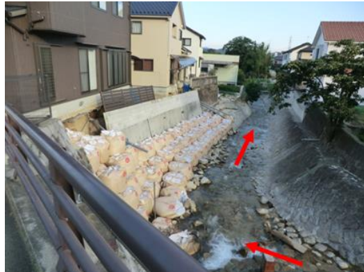
(b) 地点④での護岸の被災
