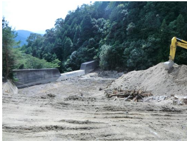
(c) 地点②の砂防堰堤での除石作業
