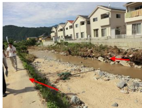
(c) 地点②での護岸の破壊と溢水
