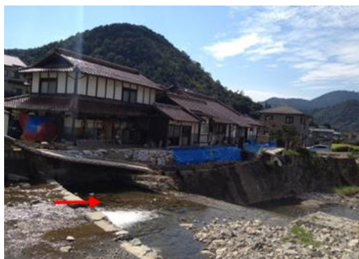
(d) 地点③での護岸の破壊
