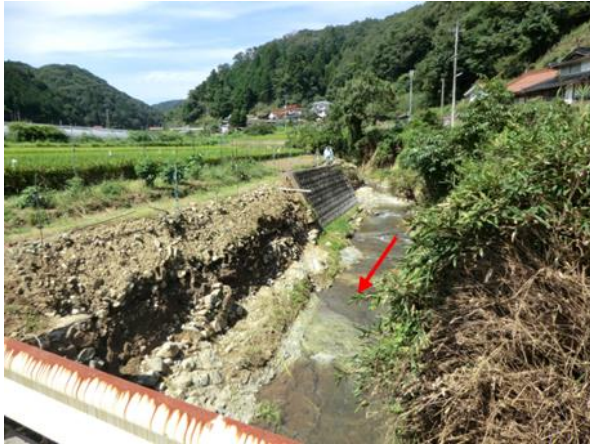
(e) 地点⑧での護岸の破壊
