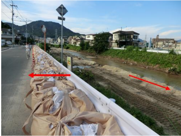
(d) 地点②での土砂堆積
