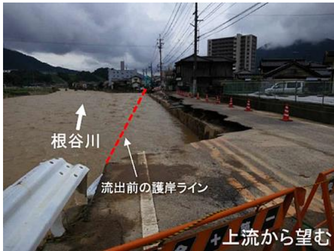
(c) 地点①での護岸の破壊
