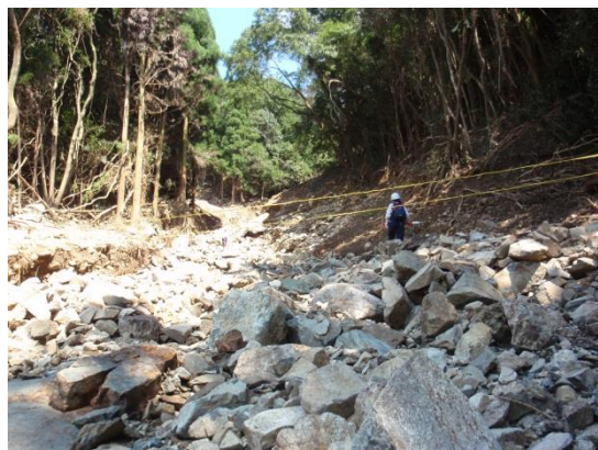
図 4-11 治山堰堤に堆積した礫
