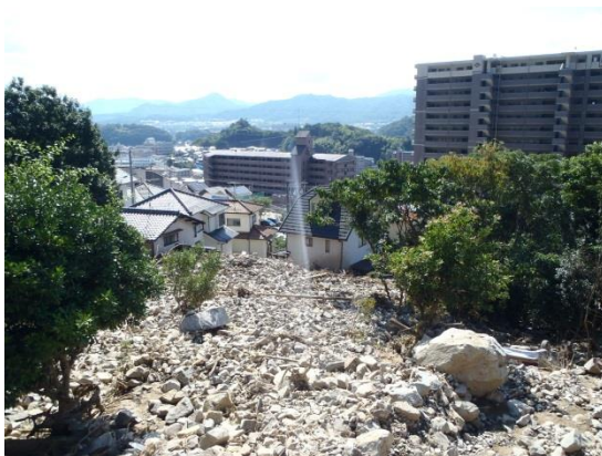
図 4-32 団地東側の流下状況
