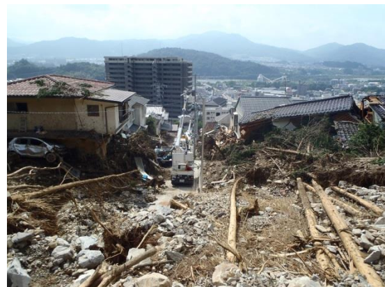
図 4-33 団地中央上部の被災状況
