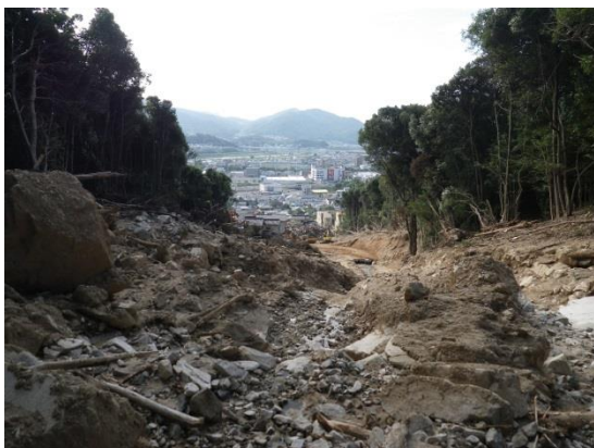
図 4-50 氾濫開始点付近から下流を望む
