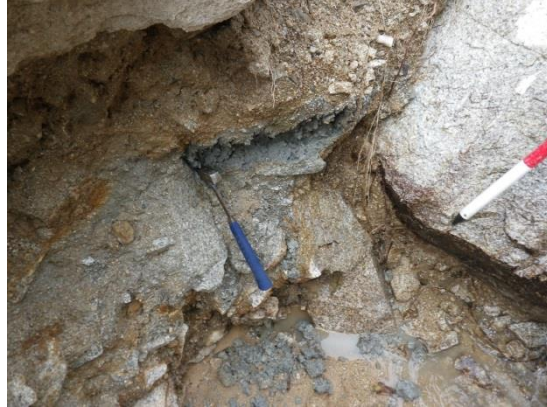
図 4-74 灰色をした砂質土
