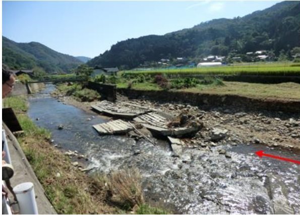
(d) 地点③での護岸の破壊と溢水
