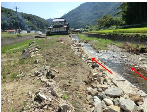
(b) 地点⑤での護岸の破壊と溢水
