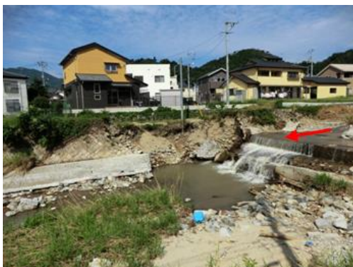
(b) 地点①での護岸の破壊
