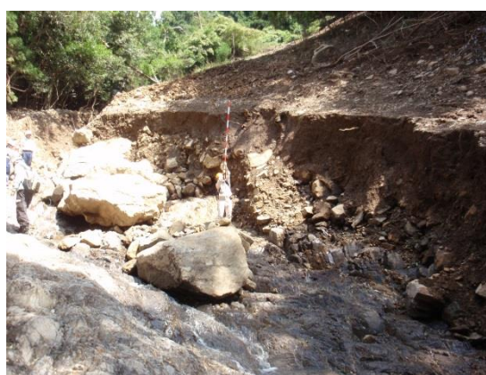
図 4-13 溪流合流部付近
