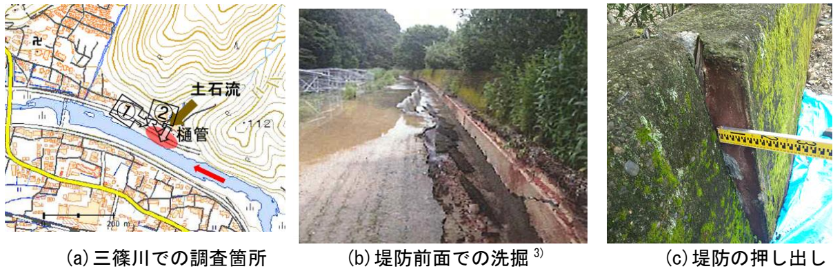
図 3-8 三篠川右岸 1K100 付近での堤防の破損
