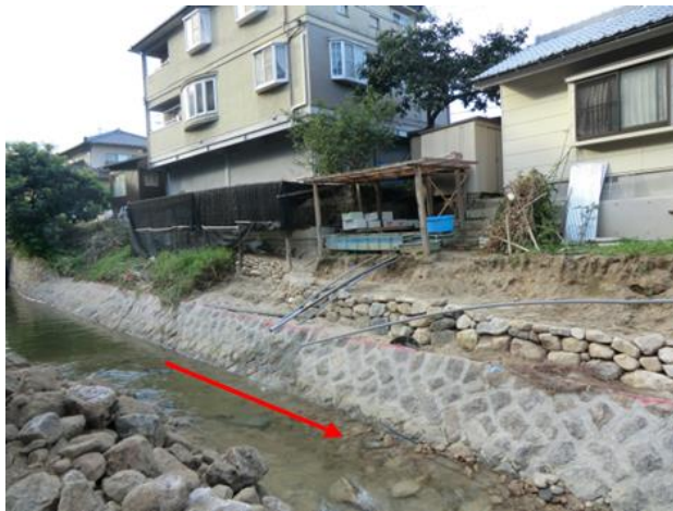
(e) 地点③での護岸の損傷
