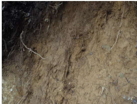
図 4-30 源頭部で見られたパイプフロー跡
