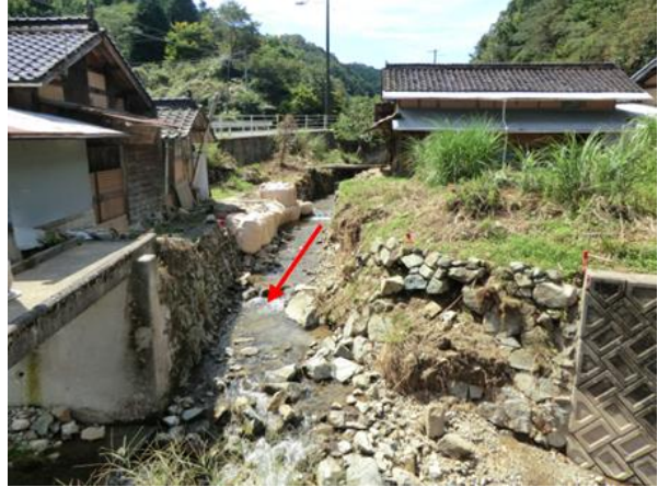
(d) 地点⑦での護岸の破壊
