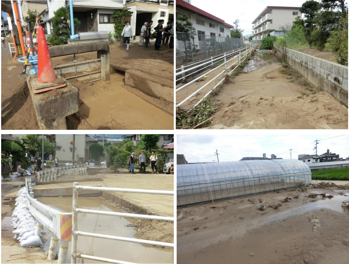
図 3-19 八木用水での土砂堆積状況（8月23日撮影）
