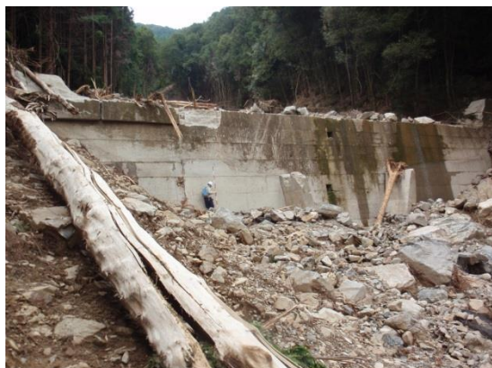
図 4-10 被災した治山堰堤の様子
