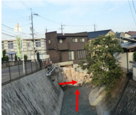
(b) 地点④での護岸の被災
