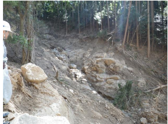
図 4-58 支流と支流の合流付近（左岸側）
