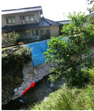
(f) 地点⑤での護岸の破壊
