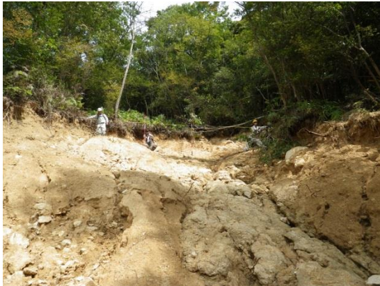
図 4-63 左岸側支流の源頭部の様子
