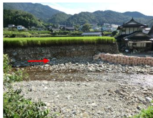
(e) 地点④での護岸の破壊
