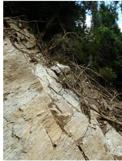
図 4-26 地点 H 付近の岩盤の様子
