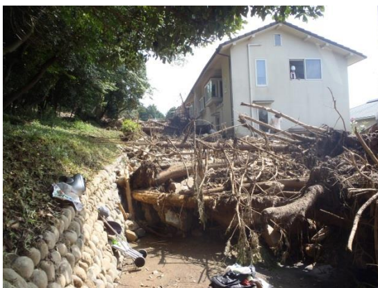
図 4-34 団地中央西側の状況
