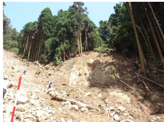
図4-20 左岸側に見られて小規模崩壊
