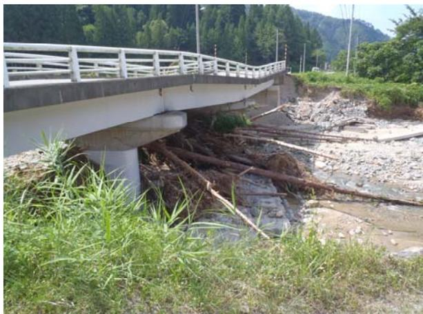
PH33 土砂, 流木による橋損傷
