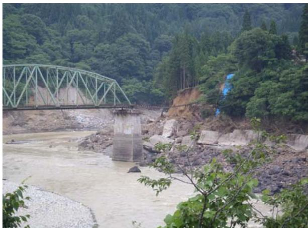
PH10 只見線アバットの崩壊
