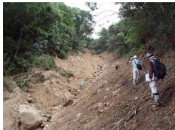
写真-5a.8 表層崩壊発生箇所と土石流の流下部
