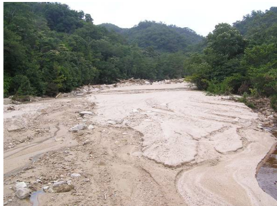
写真-5g.6 本流治山ダムの土砂堆積状況
