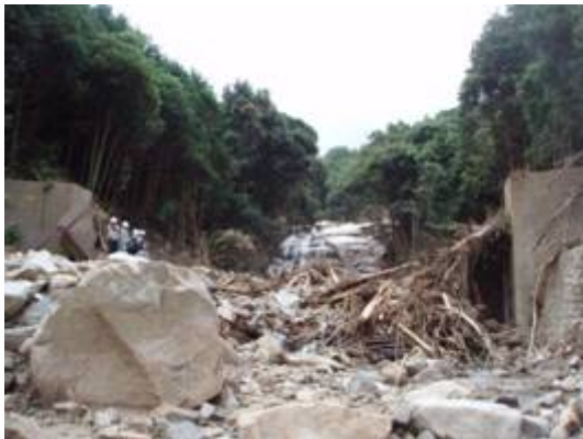
写真-5a.5 鋼製スクリーンタイプの治山ダム被災状況
