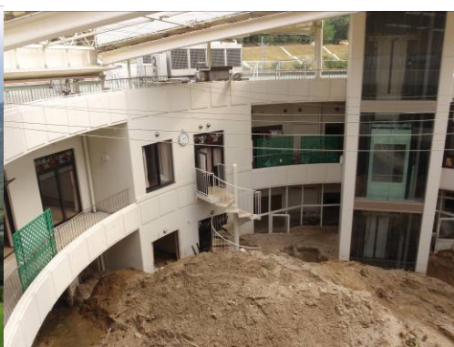
写真-5.1 花崗岩の丘陵地と山際の集落 写真-5.2 土砂が流入した老人ホーム
