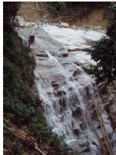
写真-5a.6 治山ダム直上流の滝 滝から上流は岩盤が露出
