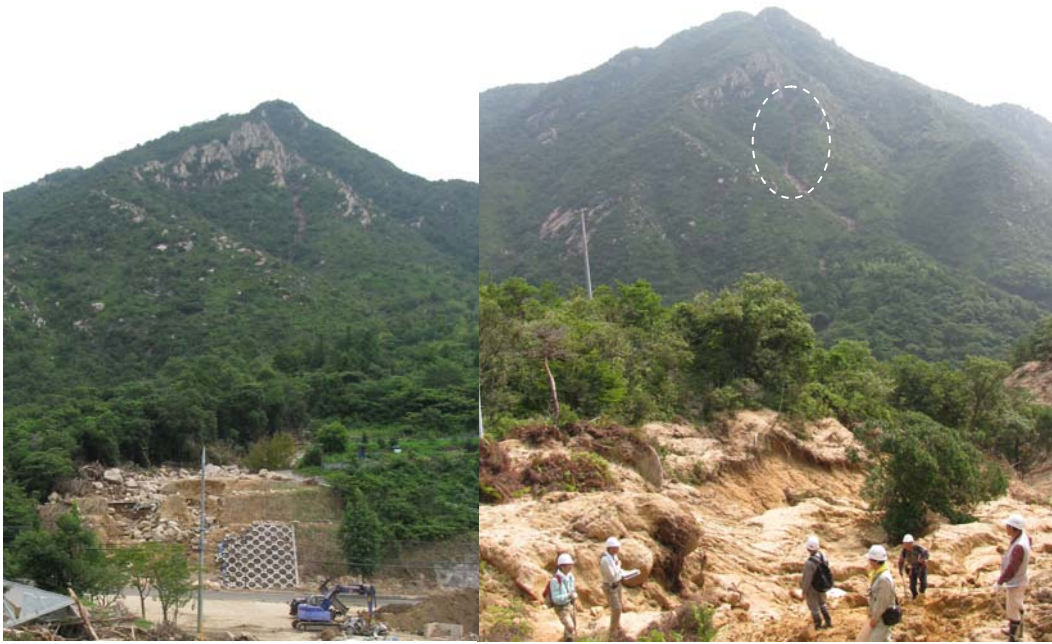
写真-5e.1 (左) 国道東側斜面(右田ヶ岳)で発生した土石流とプレキャスト法砕工 (右) 西目山から右田ヶ岳を眺望 (破線内に源頭部)
