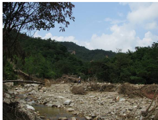
写真-5f.4 下流側の土石や流木が堆積した状況
