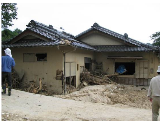
写真-5f.1 土砂や流木が家屋に流入した状況
