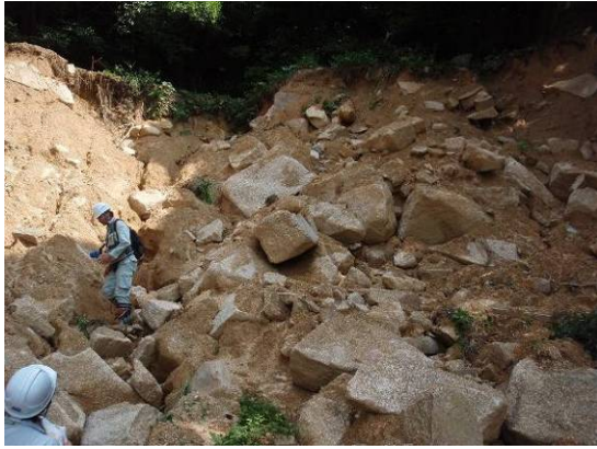
写真-5h. 3 崩壊部の状況
