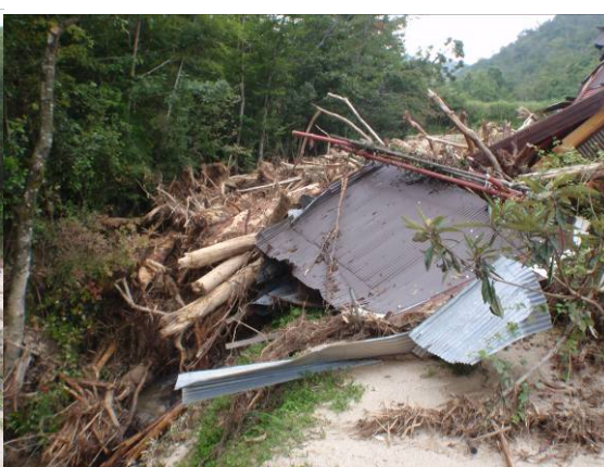
写真-5d.2 南側の谷の流路の閉塞
