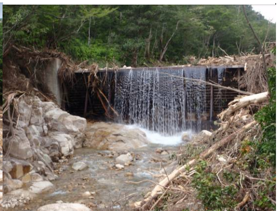
写真-5c.5 支流との合流点付近の状況 写真-5c.6 流木・土砂を捕捉した既設ダム
