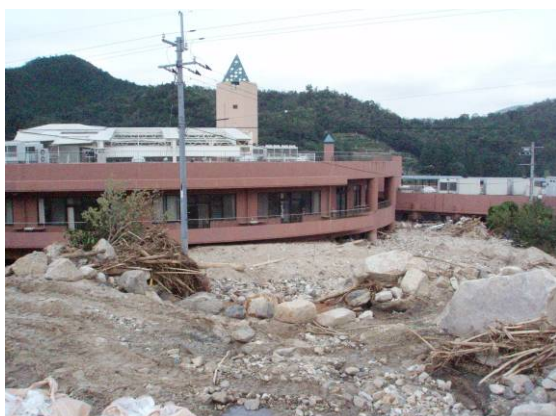
写真-5a.1 特別養護老人ホームの被災状況
