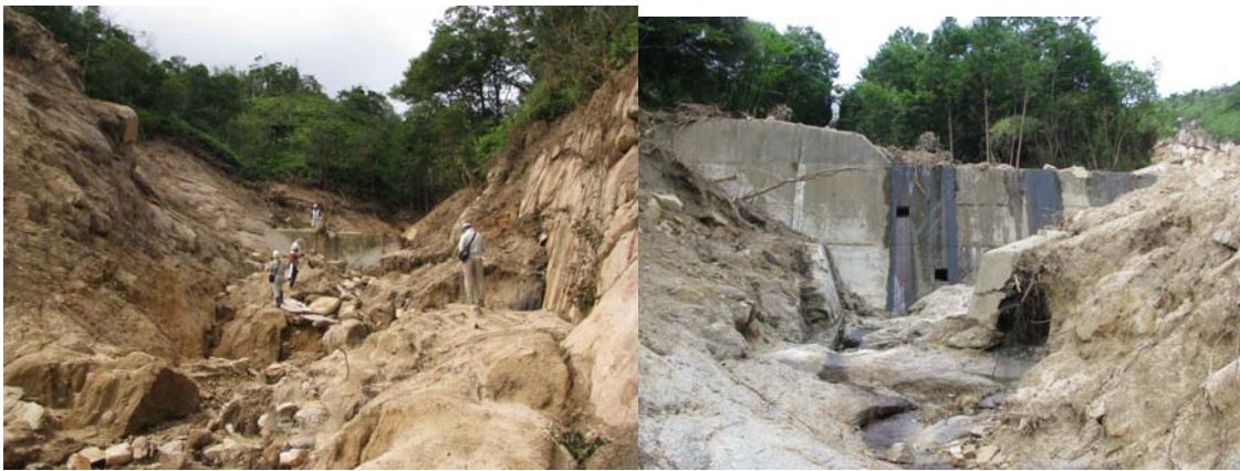
図-5e.8 中流域の状況（奥に山腹工がみえる） 図-5e.9 下流側の治山ダム
