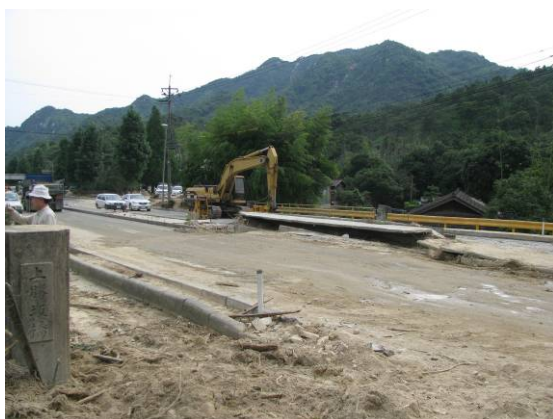
写真-5f.3 床版が浮き上がった上勝坂橋
