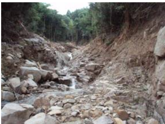
写真-5a.7 岩盤が露出する土石流の流下部
