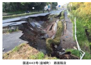
国道443号(益城町)路面陥没
