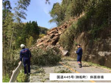
国道445号(御船町)斜面崩壊
