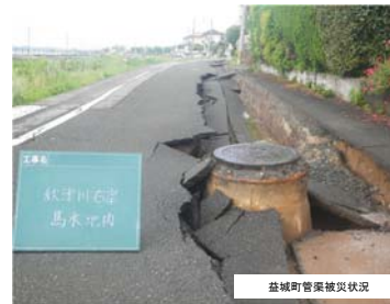
益城町管渠被災状況
