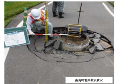
嘉島町管渠被災状況
