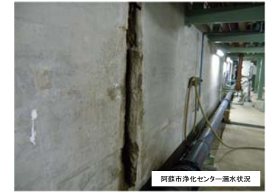
阿蘇市浄化センター漏水状況
