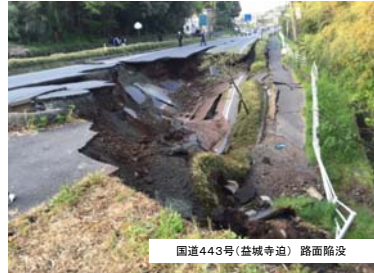
国道443号(益城寺迫)路面陥没
