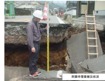
阿蘇市管渠被災状況
