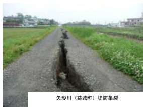
矢形川(益城町)堤防電裂
